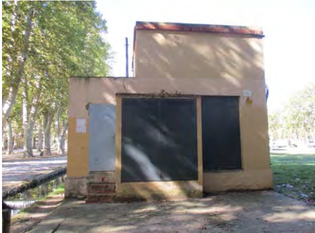
Centre de Transformació
