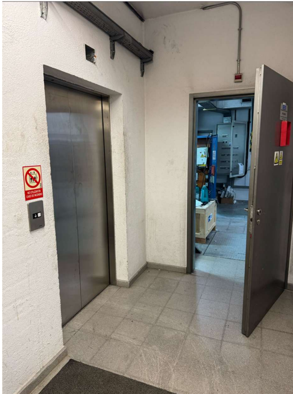
ENTRADA A SALA DE MÀQUINES ÀTIC
