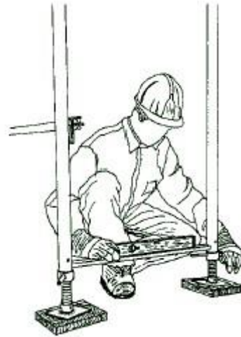
Figura 16. Comprovació de l'anivellació horitzontal
