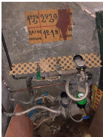
I-AIG – Bateria de comptadors d'aigua
