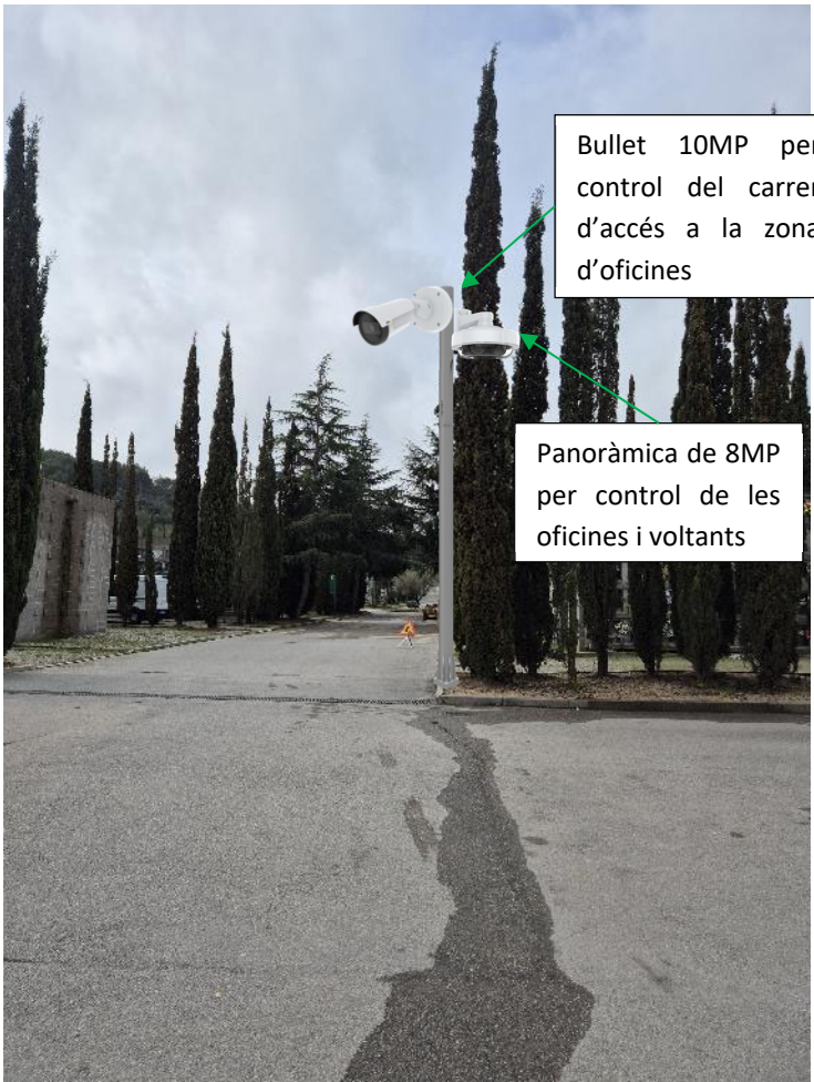
Il·lustració 269: Vista alçada d'ubicació del PdC1
