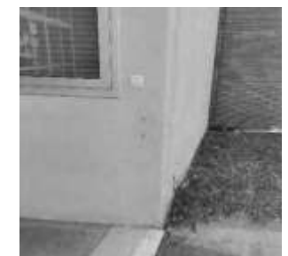
Façana interior oest
