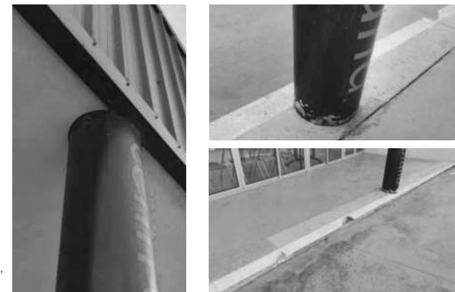
Porxo d'accés, façana nord
