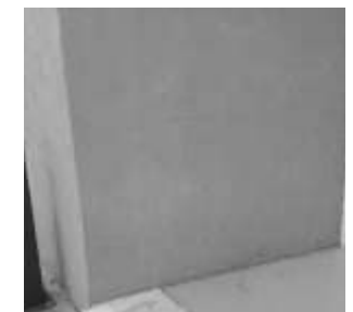
Façana interior est
