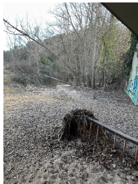
Consolidació del marge dret, per a garantir que l'aigua discorrerà per la llera
