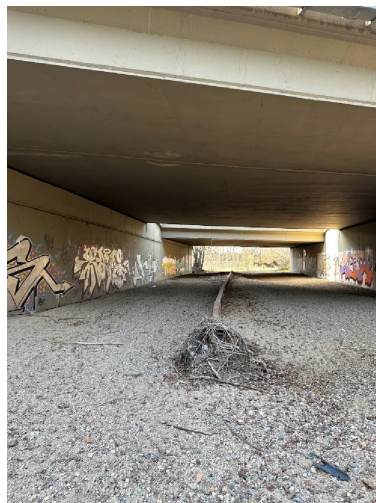
Retirada del material de la llera (80cm) per a recuperar el nivell preexistent
