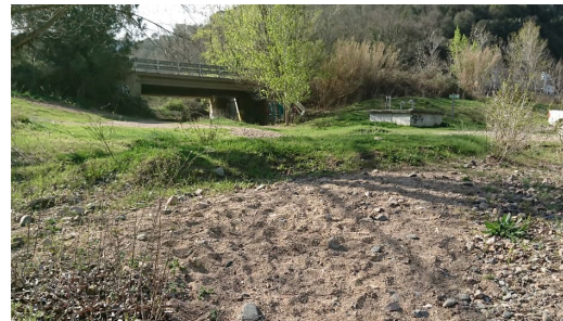
Reperfilar longitudinalment la llera per a garantir la pendent cap a la Tordera
