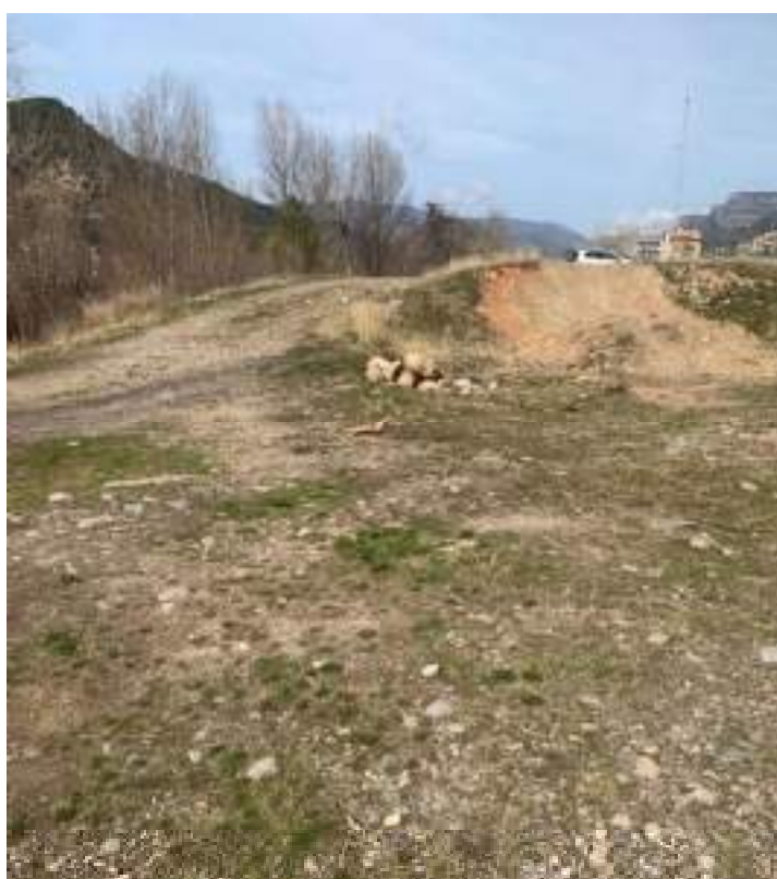
Figura 6. Final de la passarel·la
