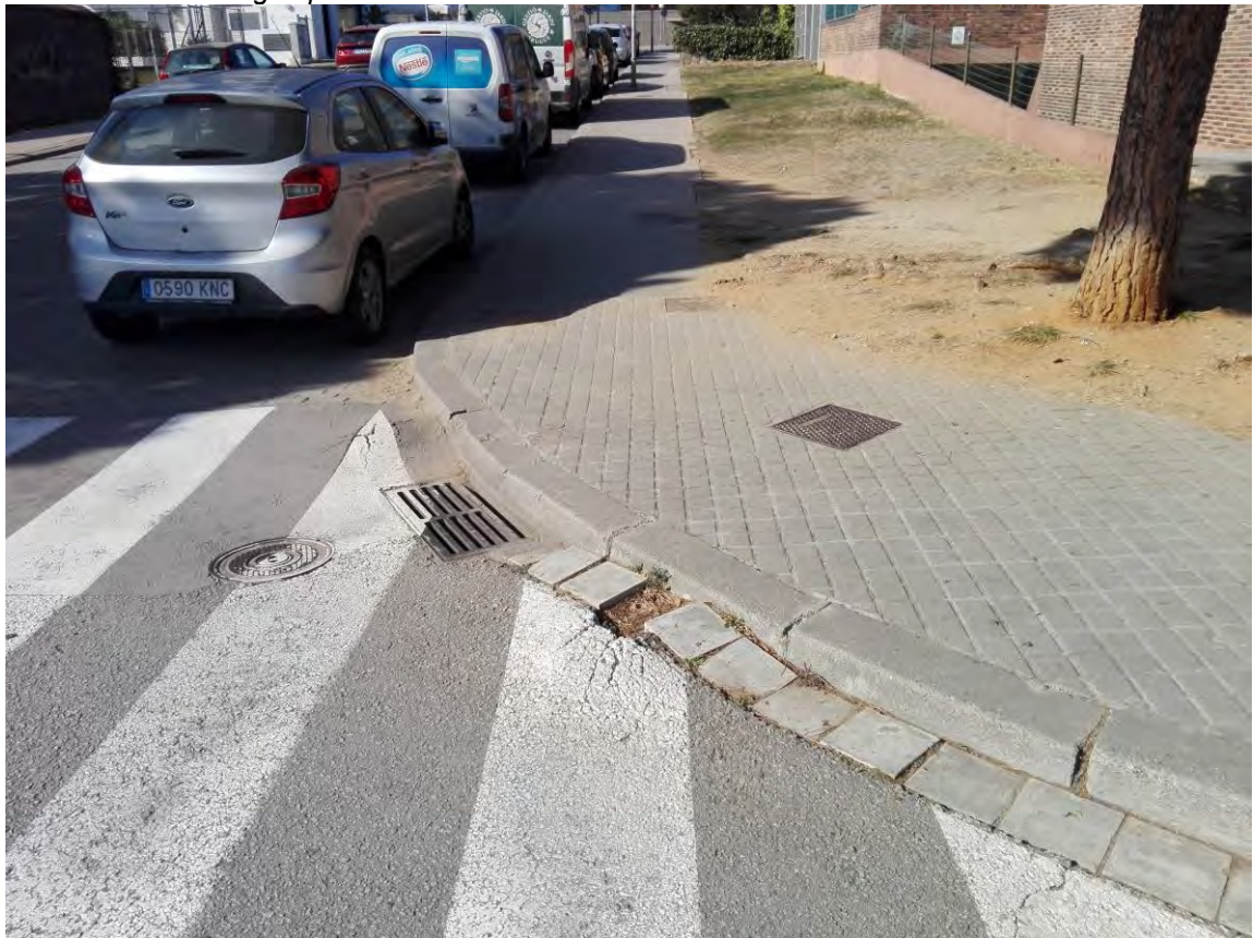
Aixecament d'un tram de rigola
