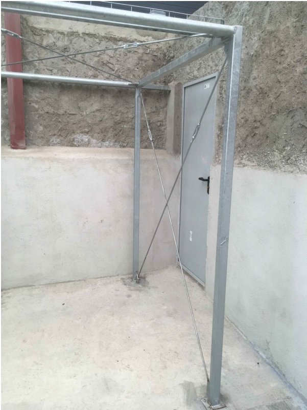
Estructura existent de l'ocellera
