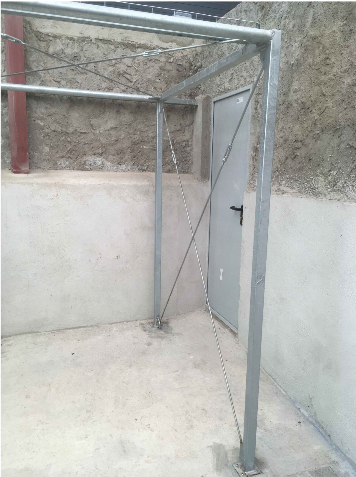
Estructura existent de l'ocellera
