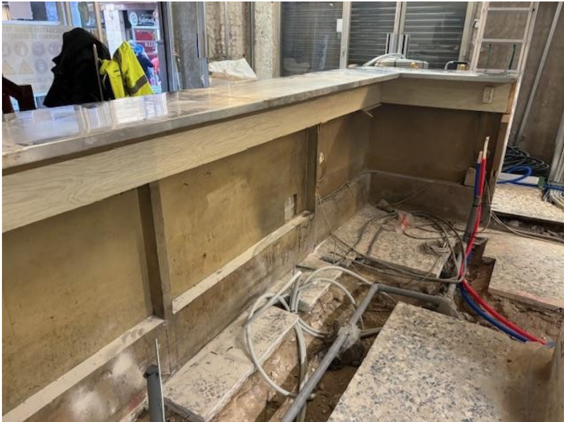
8.1 Fotografies del procés de desmuntatge i detalls generals:
