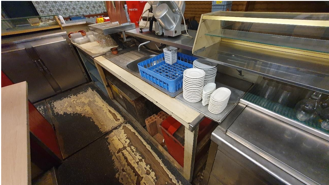
10.4 Tram 1: Vistes de la cara interior de la barra
