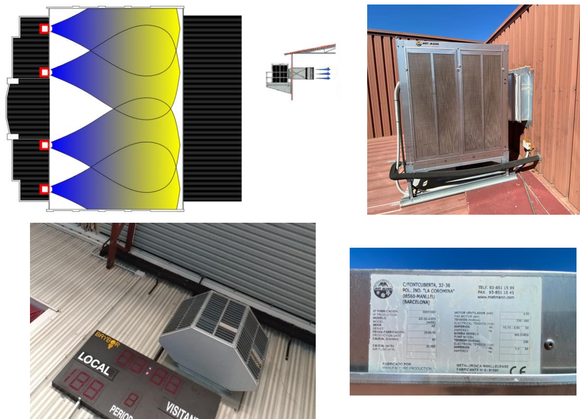
Figura 4. Distribución del aire refrigerado de los equipos evaporativos.
