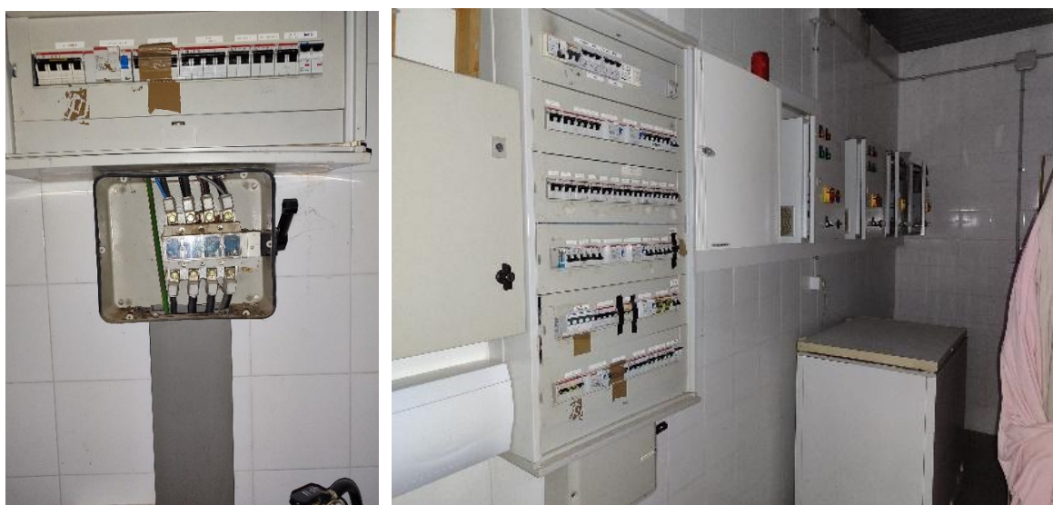
Figura 11. Izq. acometida existente de 160A. Der. Cuadros a eliminar de los equipos evaporativos
