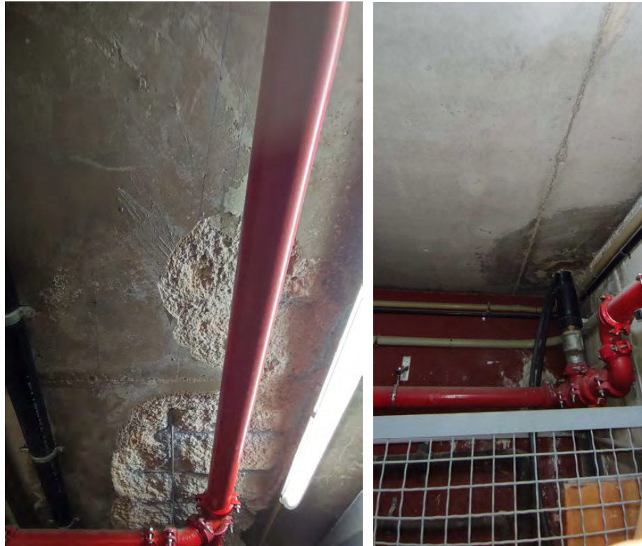
Imatge 7-1. Armat vist i humitat a una zona del sostre dels vestuaris (Windmill)
