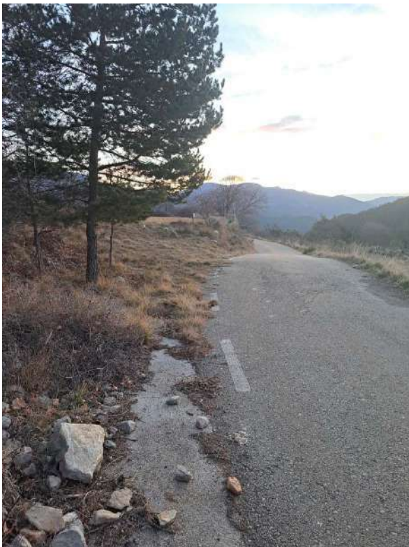
Punt 02 (cuneta de 100 cm)
