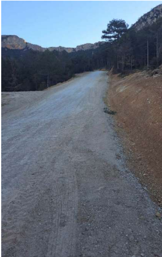
Punt 01 (Paviment amb MBC)
