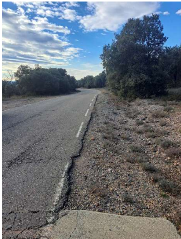
LLADURS 10 (cunetes de formigó)
