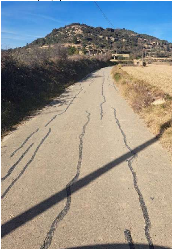
Tram 01-02 (Paviment amb MBC)
