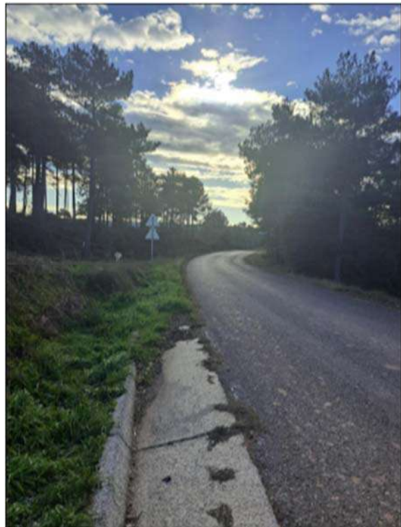
LLADURS 02 (cunetes de formigó)
