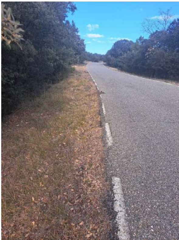
LLADURS 09 (cunetes de formigó)
