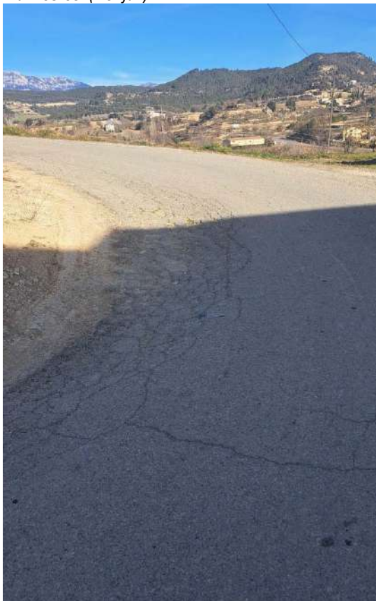
Punt 01 (Paviment amb MBC)
