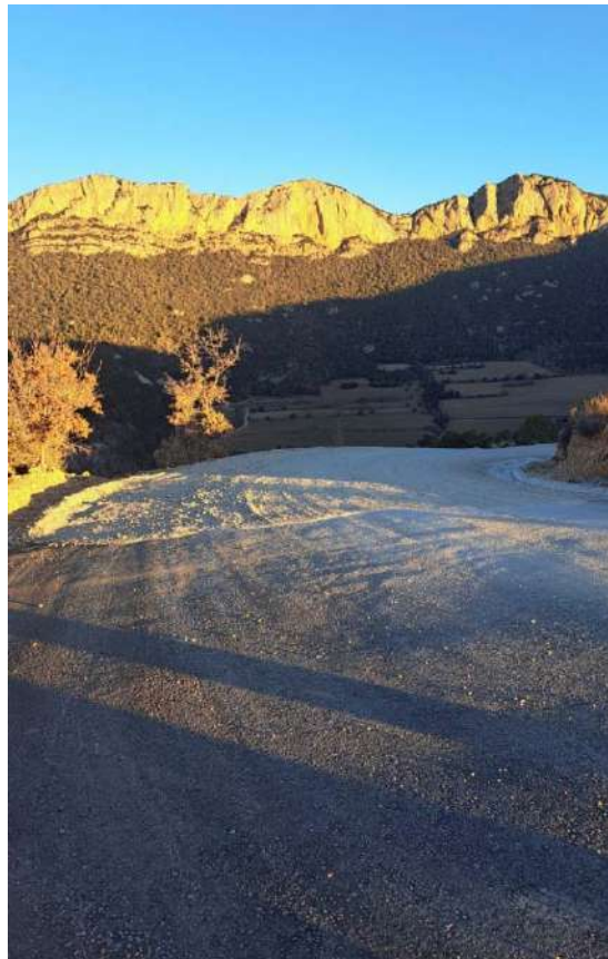
Punt 02 (Paviment amb MBC)
