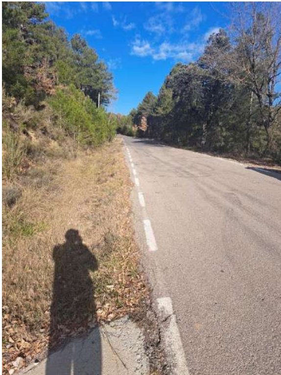
LLADURS 01 (cunetes de formigó)
