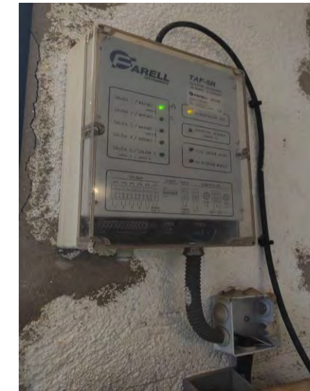
Figura 16 - Emissora control nivell dipòsit Portbou.
