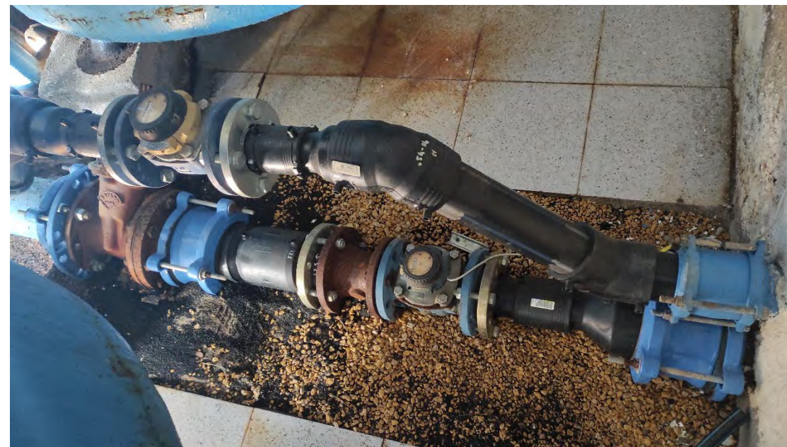
Figura 14. Comptadors sortida filtres.
