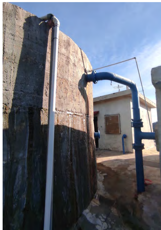
Figures 12 i 13. Sortida del decantador als filtres (1), filtres (2).
