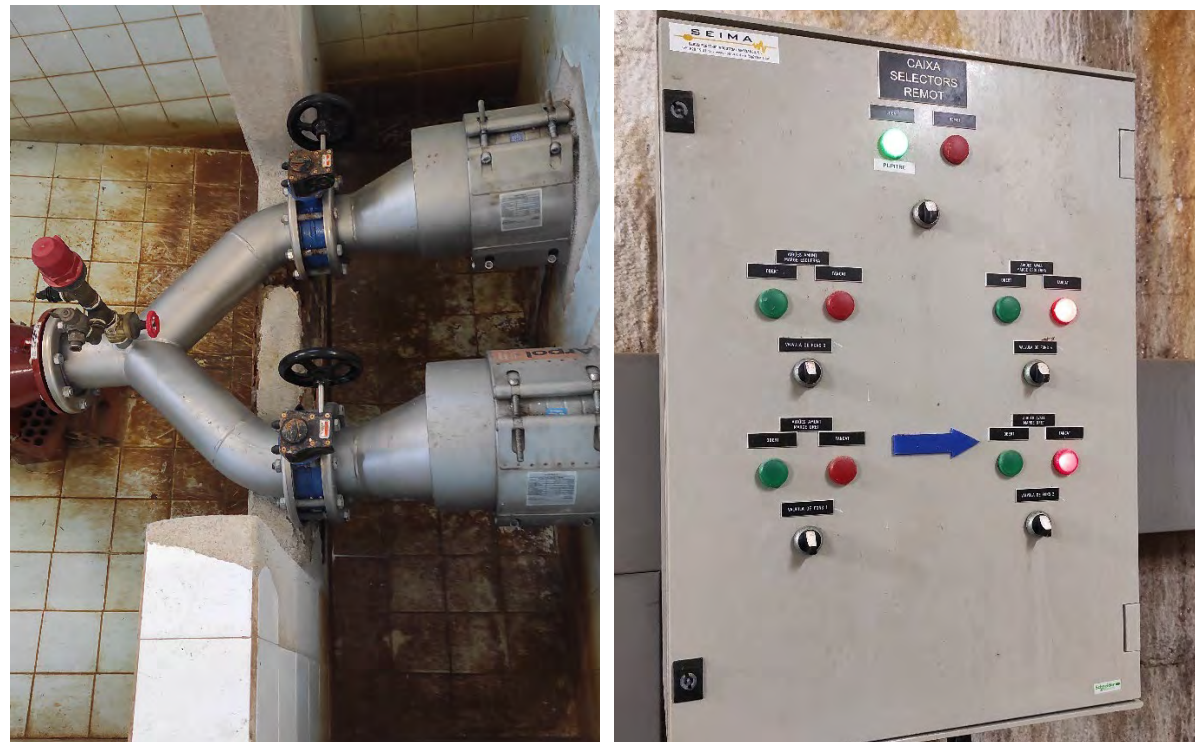
Figura 4 i 5. Col·lector sortida del pantà (1), control de vàlvules (2).
