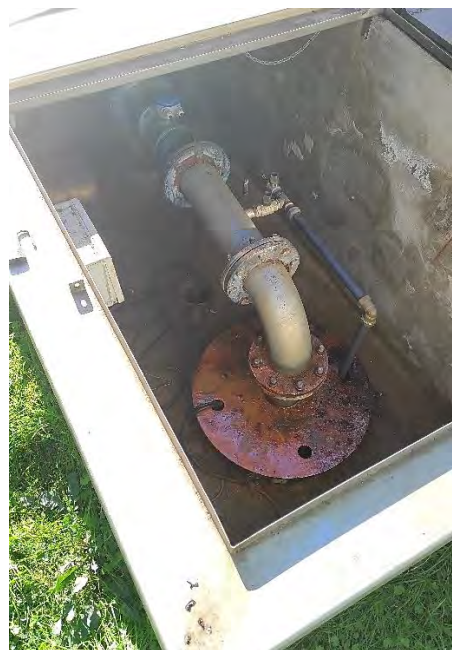
Figura 5 - Pou planta d'osmosi.
