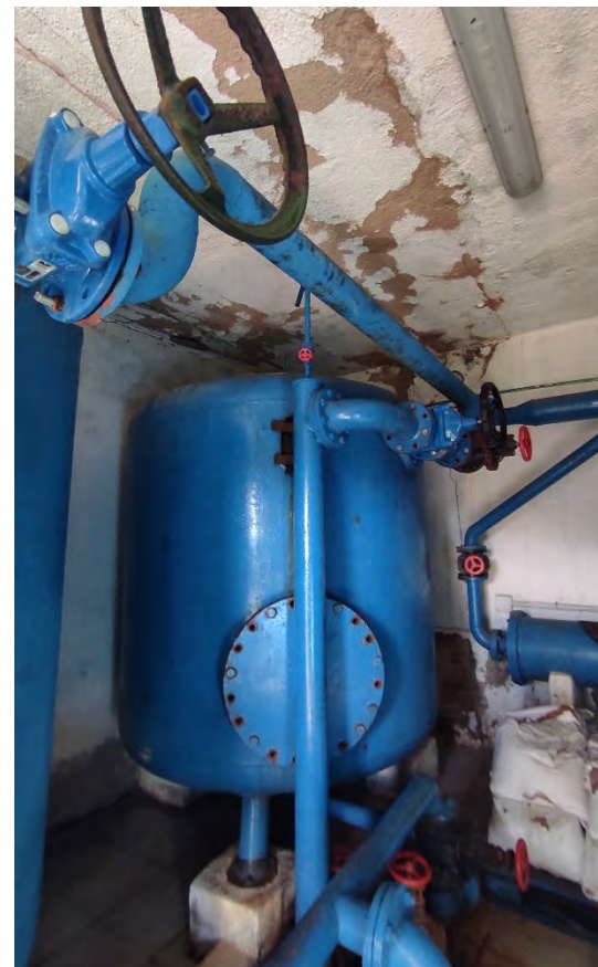
Figures 12 i 13. Sortida del decantador als filtres (1), filtres (2).
