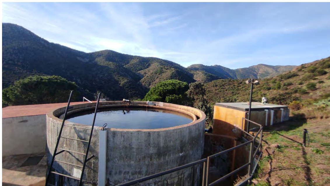
Figura 11. Decantador.
