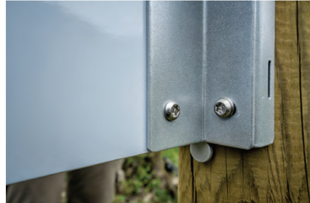
Els sistemes de fixació de la banderola al suport solen variar segons els fabricants. Cal valorar especialment la seva solidesa i la facilitat de muntatge.
