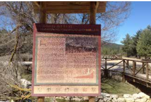
Plafó deteriorat per l'acció solar
