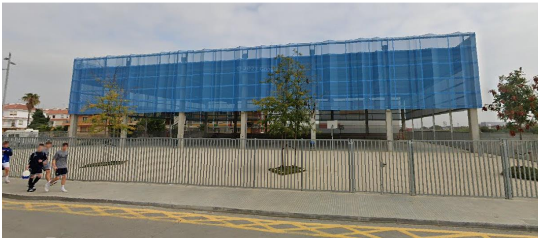
Figura 2. Imatge de l'estructura existent on es posarà la instal·lació fotovoltaica.
