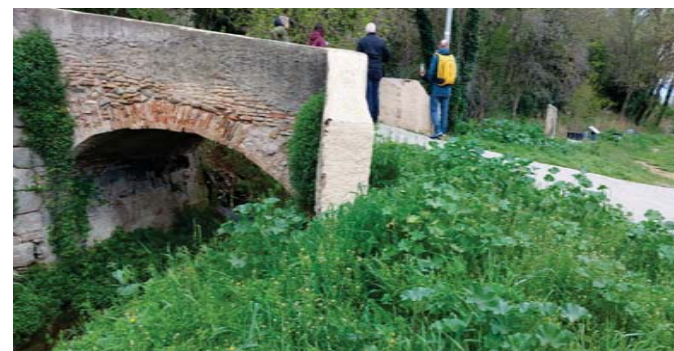
Pont per creuar el canal de rec
