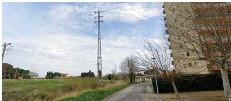
Final en suport metàl·lic de línia MT aèria a retirar
