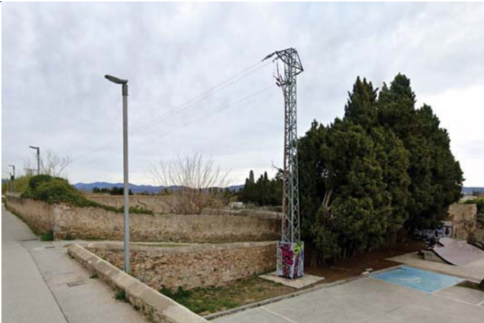
Figura 2: Línia aèria de mitjà tensió (LAMT) “Empúries 25 kV” des del suport metàl·lic existent MT.
