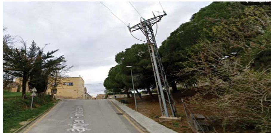
Suport al carrer Portal de la Mercè a retirar i línia aèria a retirar
