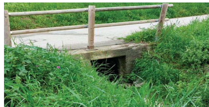
Sortida canalització rec. Estructura on s'adossarà l'estructura metàl·lica.
