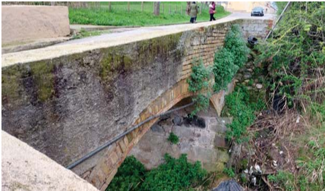
Zona del Pont per adossar els tubular de inox
