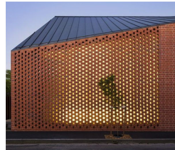
OBRA VISTA I GELOSIES
