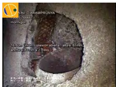
26648_f2e8b2ea-bc90-4071-88b5-e0e45aac05c_20220627_145313_679.jpg, 00:02:01, 16.80 Unión, conexión abierta,, altura: 81mm, anchura: 81mm a 2 Reloj
