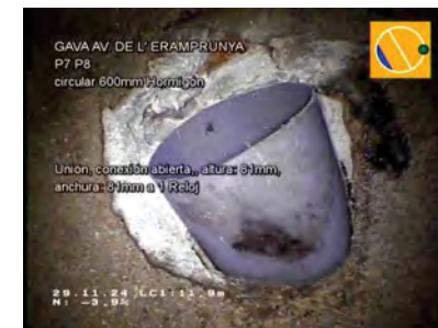
P7 A P8_9762d30f-ed56-4c89-bb15-0162bd449bb7_20241129_08 5929_198.jpg, 00:01:41, 11.90m Unión, conexión abierta., altura: 81mm, anchura: 81mm a 1 Reloj
