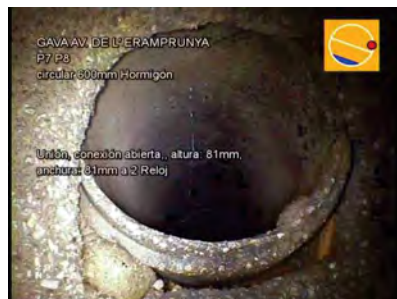
P7 A P8_3053da65-114c-41ae-8d7b-34054476faa2_20241129_08 5751_751.jpg, 00:00:21, 2.50m Unión, conexión abierta., altura: 81mm, anchura: 81mm a 2 Reloj
