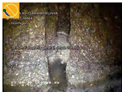
26646_9e46fe0d-16ee-4dc5-8697-4231b9941486_20220627_140645_206.jpg, 00:05:57, 38.80 Fotografía general, desde 3 Reloj a 9 Reloj / JUNTA ABIERTA
