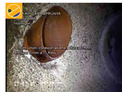
26648_06c852bb-fadc-43b0-b234-e20ac0df372a_20220627_145543_719.jpg, 00:04:02, 36.80 Unión, conexión abierta,, altura: 81mm, anchura: 81mm a 11 Reloj
