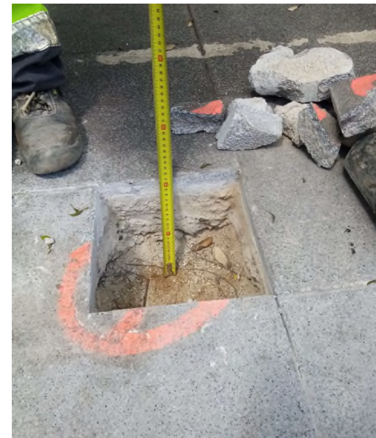
Figura 2: Detall d'una de les cales per la vorera actual.
