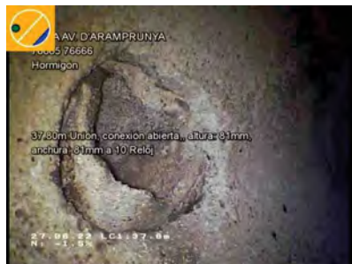
26648_3de7ef2c-c05e-4712-9c72-66dfe6d78dbf_20220627_145602_351.jpg, 00:04:12, 37.80 Unión, conexión abierta., altura: 81mm, anchura: 81mm a 10 Reloj
