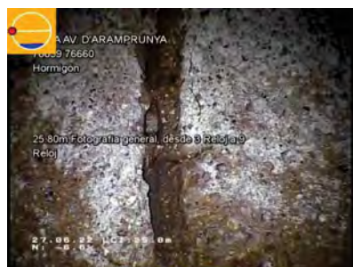
26642_18c3abbe-8e30-401f-b346-f7354bb26771_20220627_114857_946.jpg, 00:07:07, 25.80 Fotografía general, desde 3 Reloj a 9 Reloj / JUNTA ABIERTA
