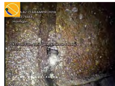
26646_b8b4e575-3ab5-4916-b486-a9f74b06b447_20220627_140732_585.jpg, 00:06:28, 41.00 Fotografía general, desde 6 Reloj a 9 Reloj / JUNTA ABIERTA
