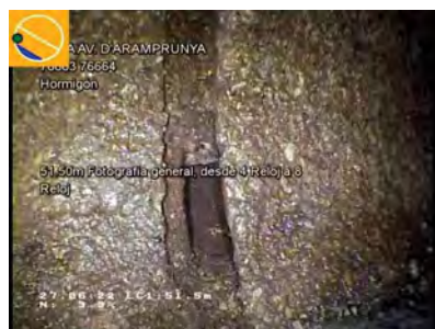
26646_8f01ccf0-99d0-47bf-903a-e77d0d8f0a95_20220627_141102_806.jpg, 00:08:53, 51.50 Fotografía general, desde 4 Reloj a 8 Reloj / JUNTA ABIERTA
