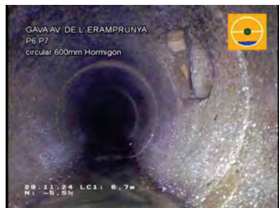
P6 A P7_ab9604cb-4857-459c-8fd4-ef87c1e81434_20241129_084840_536.jpg, 00:00:40, 6.70m Unión, conexión abierta., altura: 81mm, anchura: 81mm a 2 Reloj
