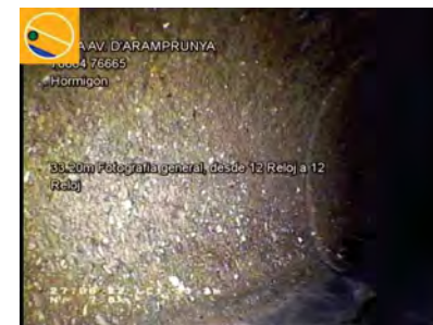
26647_a4a1bf24-a6d3-4dab-946f-d803d04dc686_20220627_143817_359.jpg, 00:03:03, 33.20 Fotografía general, desde 12 Reloj a 12 Reloj / DESGASTE
