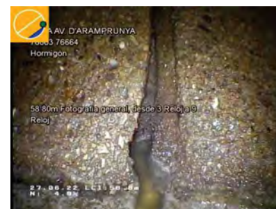
26646_27a73f84-afef-4571-93ab-a7e77965bc4b_20220627_141250_613.jpg, 00:10:08, 58.80 Fotografía general, desde 3 Reloj a 9 Reloj / JUNTA ABIERTA
