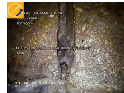
26646_a1bdc608-e6c1-45d8-a6ff-41a31c83690b_20220627_140818_543.jpg, 00:06:59, 44.10 Fotografía general, desde 3 Reloj a 6 Reloj / JUNTA ABIERTA
