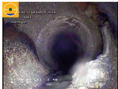
26646_bda54755-eb5f-4124-9094-7c48965ad015_20220627_135841_418.jpg, 00:00:23, 1.30 Unión, conexión abierta., altura: 81mm, anchura: 81mm a 1 Reloj
