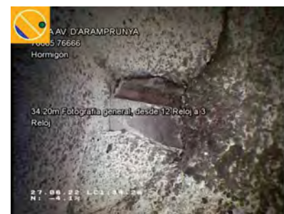
26648_2ca69b42-0f13-4762-b07b-f9bd3b30aa08_20220627_145515_775.jpg, 00:03:45, 34.20 Fotografía general, desde 12 Reloj a 3 Reloj / ROTURA
