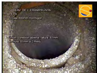
P8 A P9_402d78f2-a70d-4c3e-bc05-0cbe929e7383_20241129_090 456_012.jpg, 00:00:07, 1.40m Unión, conexión abierta., altura: 81mm, anchura: 81mm a 2 Reloj
