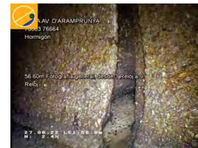
26646_8f56118d-1b68-45c2-b89d-80b8a3baf81b_20220627_141217_176.jpg, 00:09:47, 56.60 Fotografía general, desde 3 Reloj a 9 Reloj / JUNTA ABIERTA
