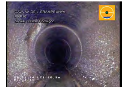
P9 A P10_8c1bc221-5dd6-43dc-a834-6df3536e324f_20241129_104501_376.jpg, 00:01:02, 10.30m Unión, conexión abierta,, altura: 81mm, anchura: 81mm a 10 Reloj
