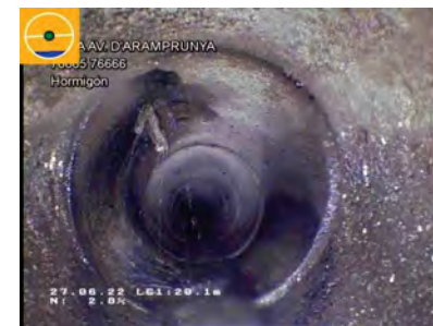
26648_55a7b03e-2bce-4849-b4a3-96e55a3ee381_20220627_145356_902.jpg, 00:02:27, 20.10 Unión, conexión abierta,, altura: 81mm, anchura: 81mm a 11 Reloj
