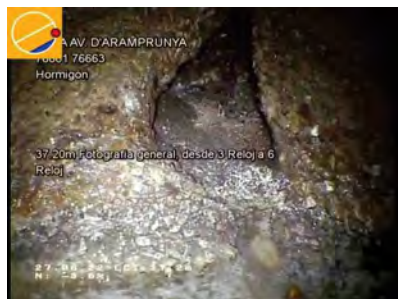
26645_a46dfa85-3f42-420d-8aef-bdb8e20455ef_20220627_131412_210.jpg, 00:05:12, 37.20 Fotografía general, desde 3 Reloj a 6 Reloj / JUNTA ABIERTA
