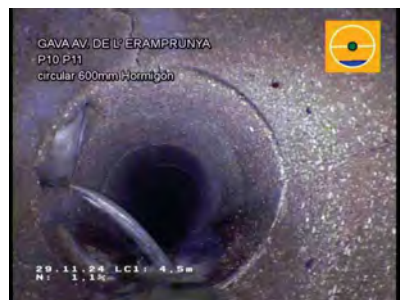
P10 A P11_20ef45ab-8ceb-4c00-9b04-ce92927f438d_20241129_101710_925.jpg, 00:00:38, 4.50m Unión, conexión abierta., altura: 81mm, anchura: 81mm a 10 Reloj
