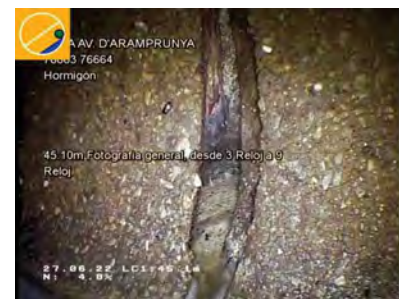
26646_d0892604-3ec3-4cc8-98ed-0be655e893f2_20220627_140844_832.jpg, 00:07:17, 45.10 Fotografía general, desde 3 Reloj a 9 Reloj / JUNTA ABIERTA
