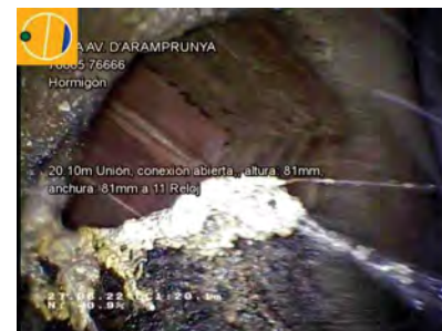
26648_d5674fb0-d4a0-4473-bdc8-65d2a54f2936_20220627_145348_321.jpg, 00:02:27, 20.10 Unión, conexión abierta,, altura: 81mm, anchura: 81mm a 11 Reloj
