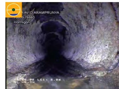
26642_01a70279-233f-4a44-b767-ff053967830d_20220627_114002_649.jpg, 00:01:26, 5.00 Fotografía general, desde 12 Reloj a 12 Reloj / DESGASTE
