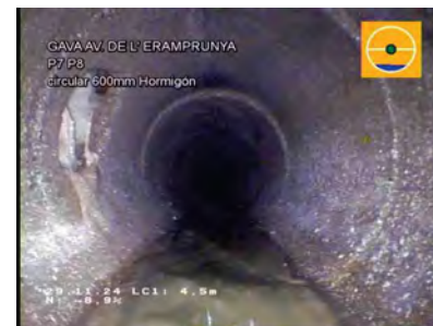
P7 A P8_2cddb09d4-049d-4a48-8812-daa2f1eca613_20241129_085 832_246.jpg, 00:00:47, 4.50m Unión, conexión abierta., altura: 81mm, anchura: 81mm a 10 Reloj
