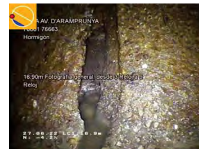
26645_5bf8ef86-e5e7-4fdd-a4a2-72b760987552_20220627_131132_634.jpg, 00:03:01, 16.90 Fotografía general, desde 3 Reloj a 9 Reloj / JUNTA ABIERTA
