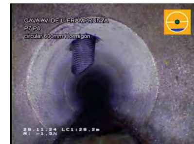
P7 A P8_ac5a84cb-39f0-437f-be1b-20b13b98bbf6_20241129_090252_297.jpg, 00:03:57, 29.20m Unión, conexión abierta., altura: 81mm, anchura: 81mm a 1 Reloj
