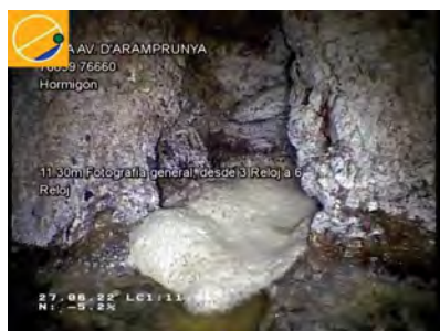
26642_e2ec29c7-b0ee-42c2-ba03-e51370c552b0_20220627_14301_079.jpg, 00:03:17, 11.30 Fotografía general, desde 3 Reloj a 6 Reloj / ROTURA EN JUNTA
