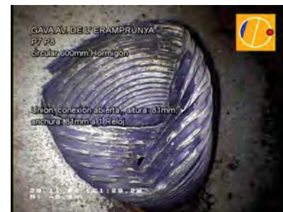
P7 A P8_512b6acb-b24c-4e69-83f6-b77fc61fe236_20241129_090244_710.jpg, 00:03:57, 29.20m Unión, conexión abierta., altura: 81mm, anchura: 81mm a 1 Reloj
