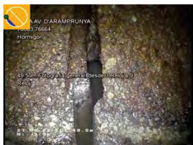
26646_e79e39ae-d882-475c-b46e-99deda3fa2ad_20220627_141026_793.jpg, 00:08:26, 49.50 Fotografía general, desde 3 Reloj a 9 Reloj / JUNTA ABIERTA
