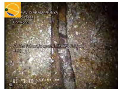
26646_ca368b9c-7854-44bb-9d21-72e689781226_20220627_141136_679.jpg, 00:09:18, 53.60 Fotografía general, desde 4 Reloj a 8 Reloj / JUNTA ABIERTA
