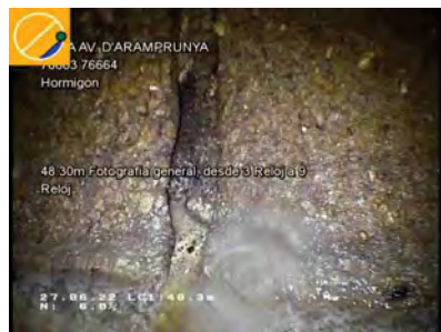
26646_fa5f167e-cf96-4064-b892-296f0bd19bd5_20220627_140954_273.jpg, 00:08:05, 48.30 Fotografía general, desde 3 Reloj a 9 Reloj / JUNTA ABIERTA
