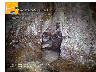
26642_8d472f5d-2a73-43bc-840f-5bd1f1276189_20220627_114950_759.jpg, 00:07:40, 28.70 Fotografía general, desde 3 Reloj a 9 Reloj / ROTURA EN JUNTA
