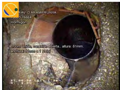
26646_d4e5f4da-4548-4e65-91a8-b9a7d2885267_20220627_135831_504.jpg, 00:00:23, 1.30 Unión, conexión abierta., altura: 81mm, anchura: 81mm a 1 Reloj
