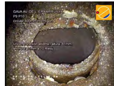
P9 A P10_1dde9e01-2756-4607-a9d2-10a67234a51e_20241129_104455_017.jpg, 00:01:02, 10.30m Unión, conexión abierta,, altura: 81mm, anchura: 81mm a 10 Reloj
