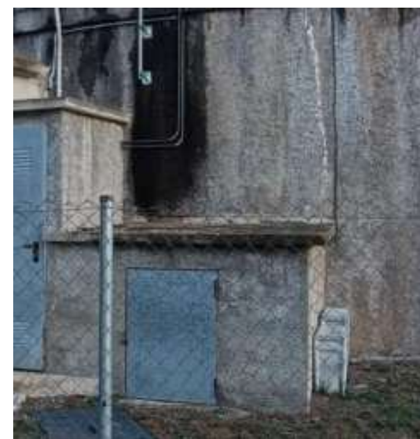
Figura 4. Vista exterior caseta de vàlvules existent
