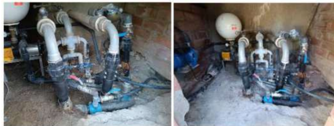
Figura 3. Vista interior de la caseta de vàlvules existent
