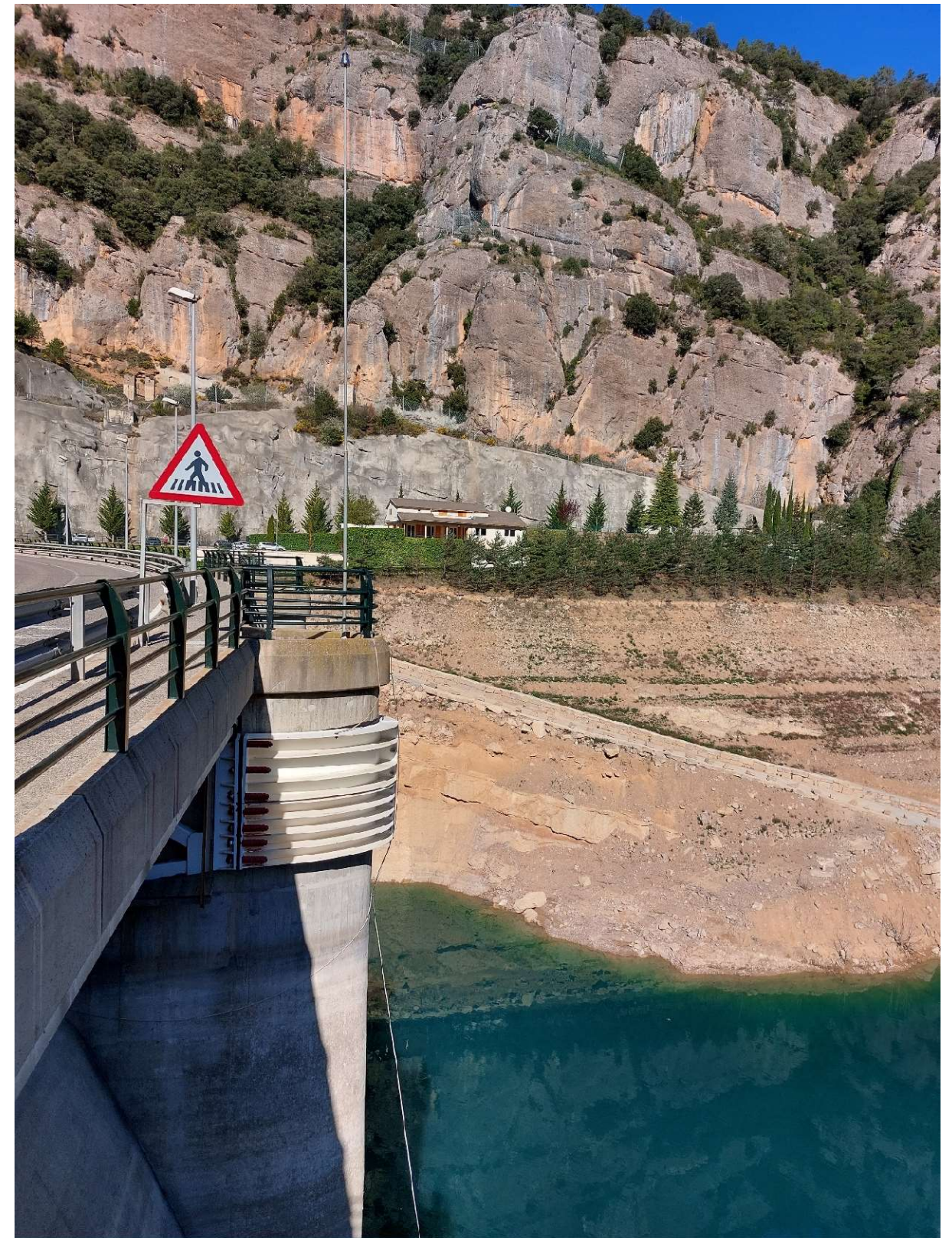
Fotografia 21. Vista del parament aigües amunt i parallamps.
