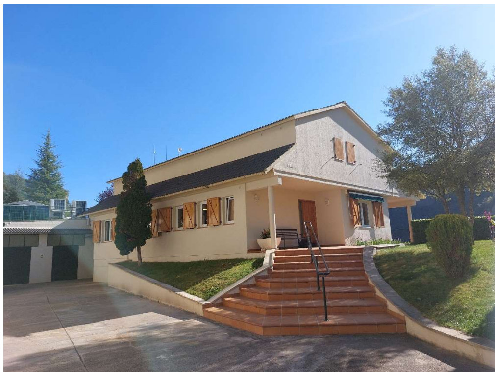
Fotografia 4. Casa d'administració de la presa de la Llosa del Cavall.
