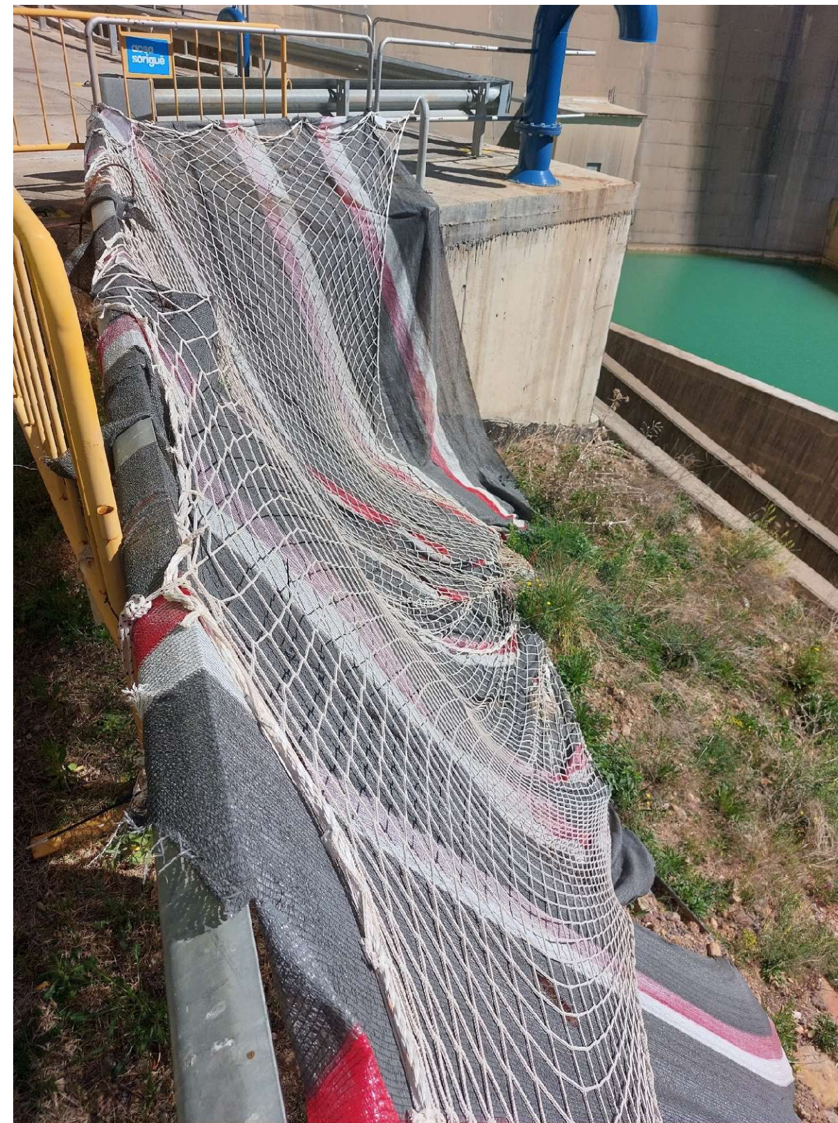
Fotografia 29. Talús del camí d'accés a la zona de la cambra de vàlvules de la línia de cabals de manteniment.
