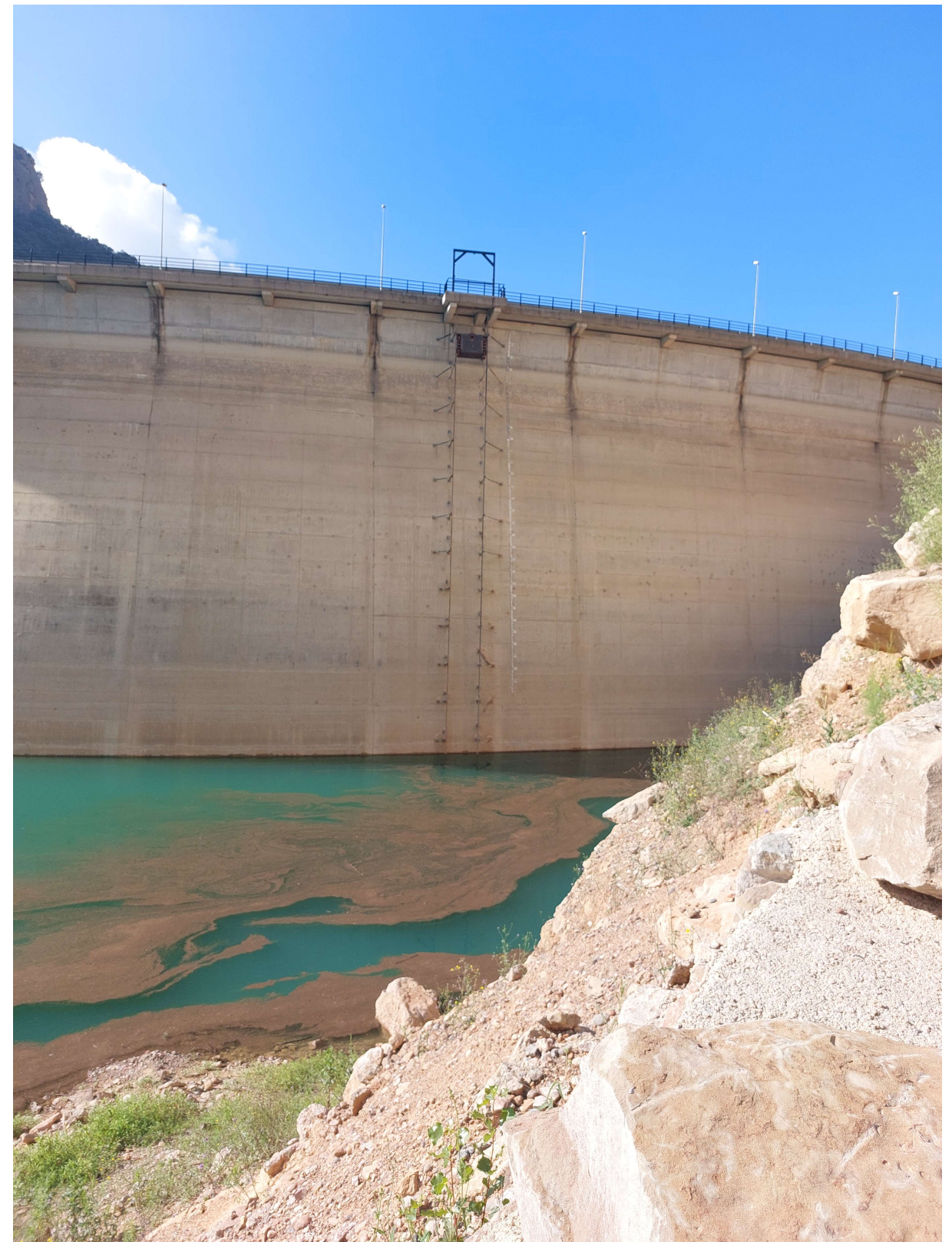
Fotografia 2. Vista de les guies i sistema d'hissat de l'atall del desguàs de mig fons
