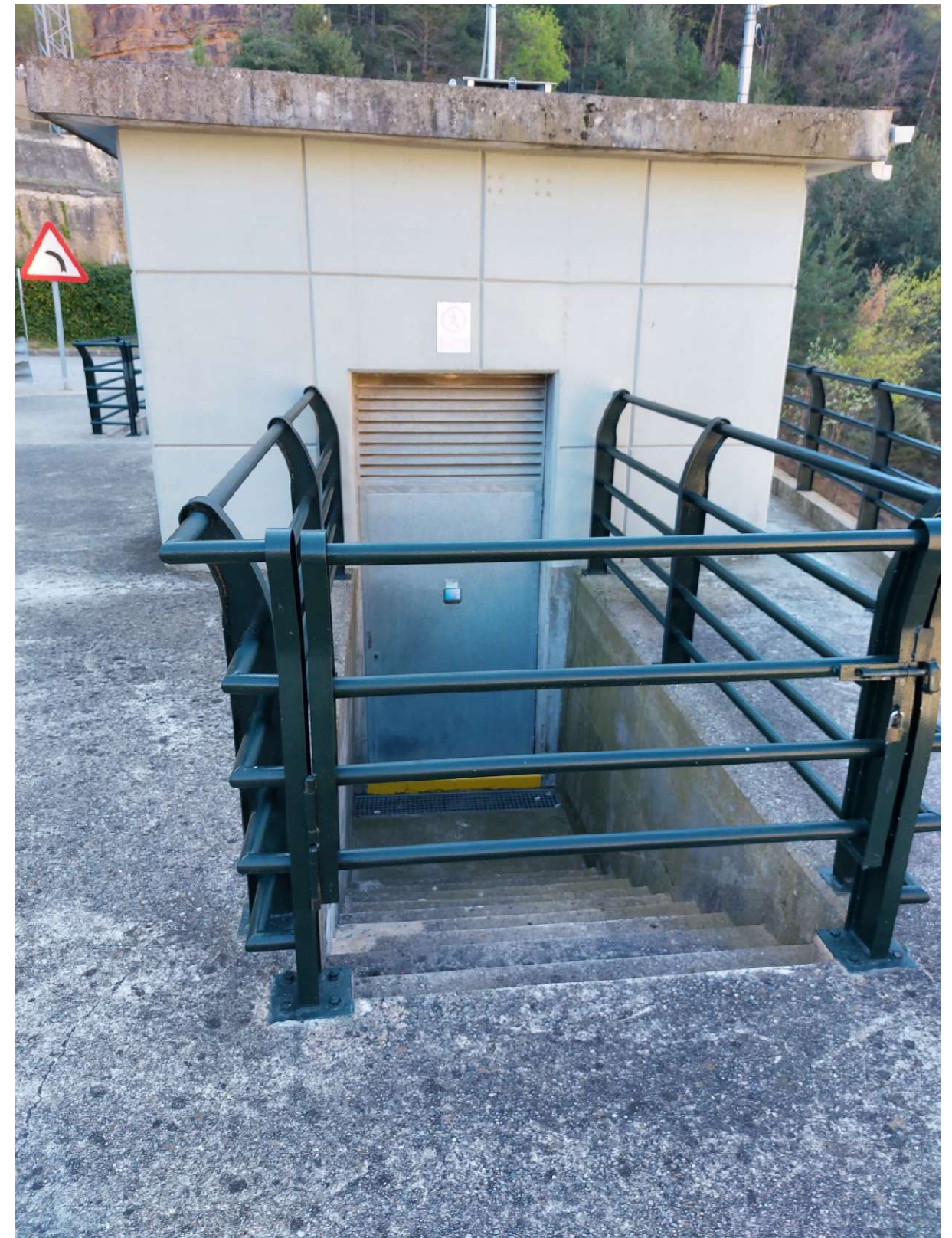
Fotografia 19. Accés a l'interior de la presa
