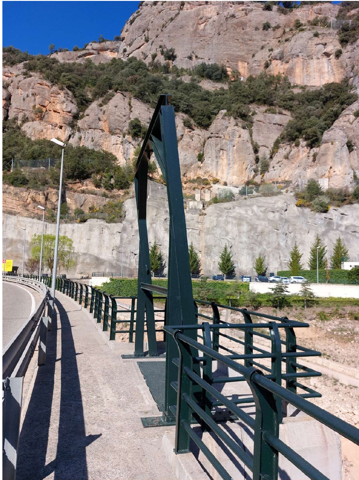
Fotografia 25. Pòrtic a coronament per a l'hissat de l'atall.
