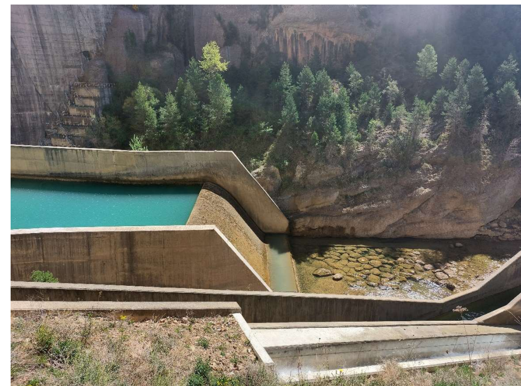
Fotografia 60. Inici ràpida de sortida a l'aire lliure de la línia de cabals de manteniment al costa del trampolí de sortida dels desguàs de mig fons.
