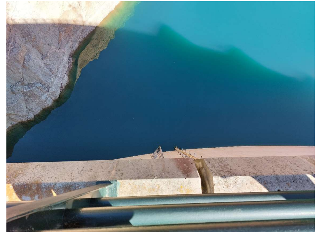
Fotografia 23. Vista de l'estructura d'hissat de l'atall.
