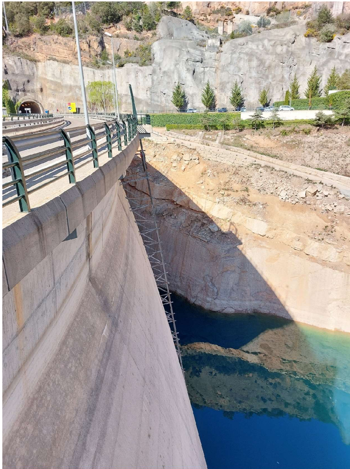
Fotografia 22. Estructura d'hissat de l'atall del desguàs de mig fons.
