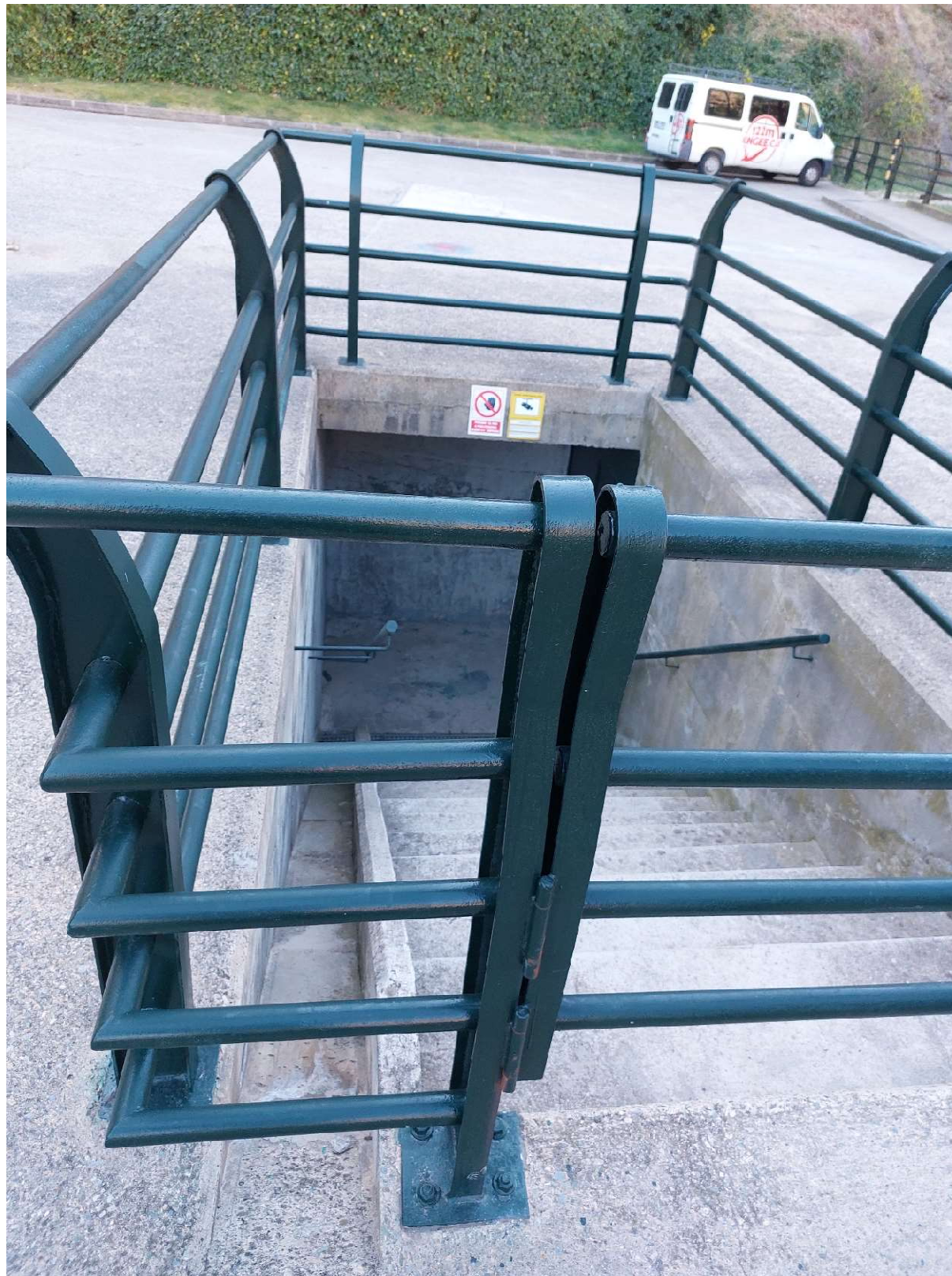
Fotografia 20. Accés a la presa.
