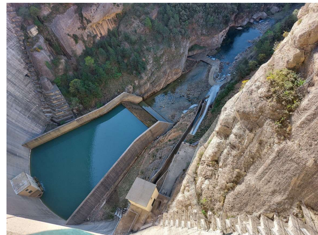
Fotografia 14. Vista del vas, caseta del desguàs de fons, de mig fons i canals de sortida dels desguàs de mig fons i línia de cabals de manteniment.
