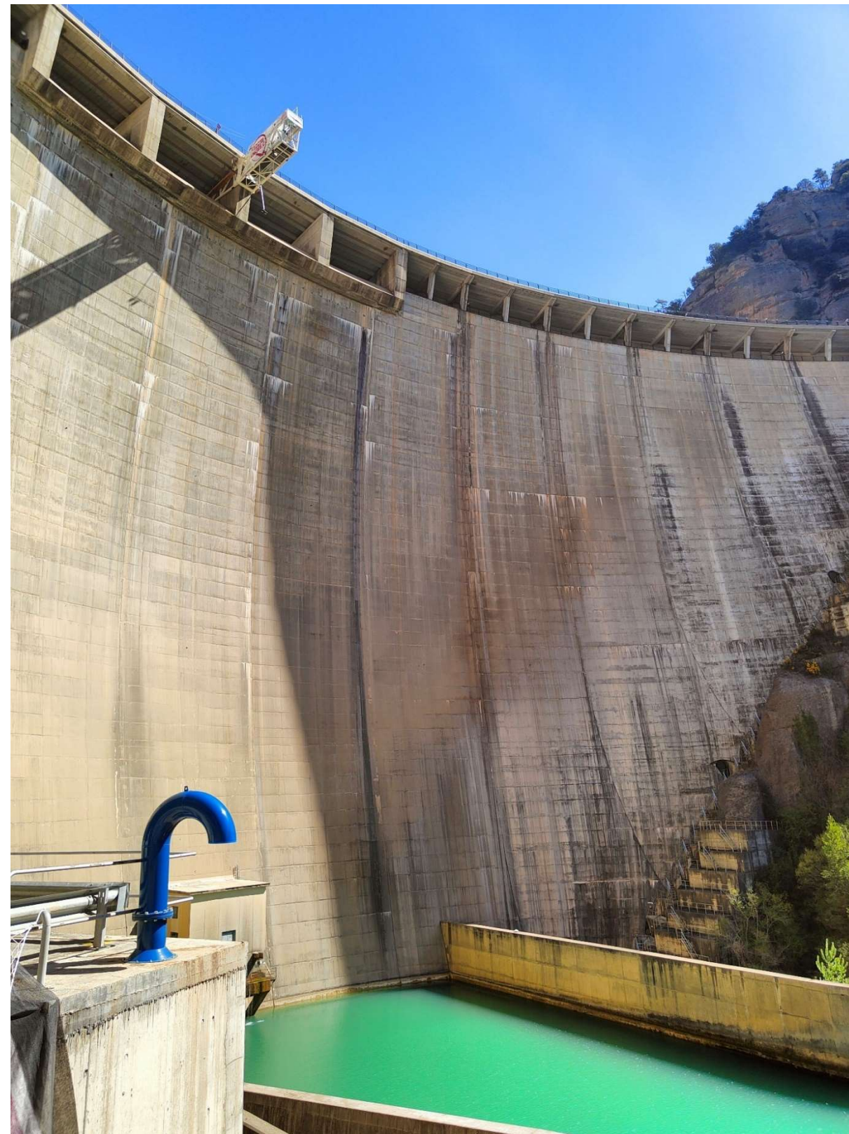
Fotografia 63. Vista de la presa de la Llosa del Cavall i la cambra de vàlvules de manteniment des del camí d'accés a peu de presa.
