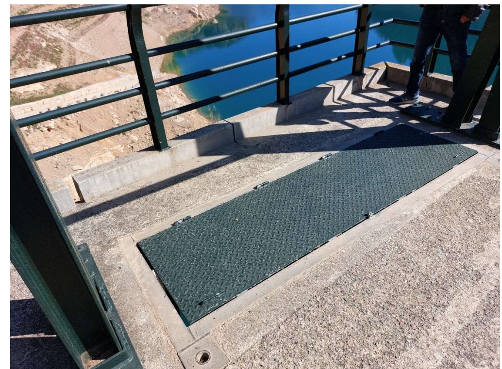
Fotografia 24. Vista de la tapa sota la que es troba l'atall.
