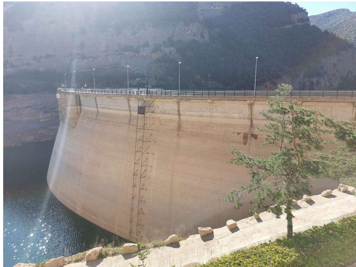
Fotografia 1. Vista del parament aigües amunt de la presa de la Llosa del Cavall on es veuen les guies i del sistema d'hissat de l'atall del desguàs de mig fons.
