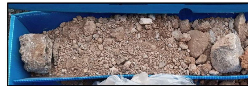
Aspecto de los materiales de pavimento y relleno de la capa R.
