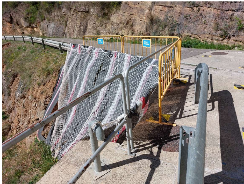
Fotografia 28. Talús del camí d'accés a la zona de la cambra de vàlvules de la línia de cabals de manteniment.
