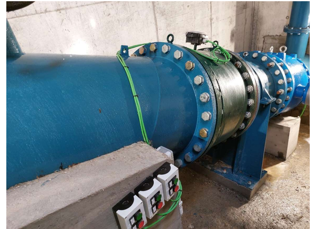
Fotografia 46. Cabalímetre electromagnètic DN700.
