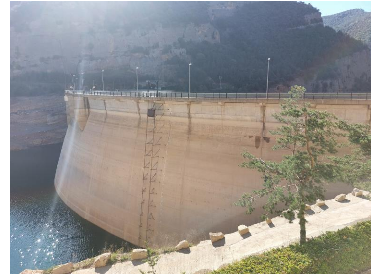
Figura 1. Vista del parament d'aigües amunt de la presa i l'estructura d'hissat de l'atall del desguàs de mig fons
