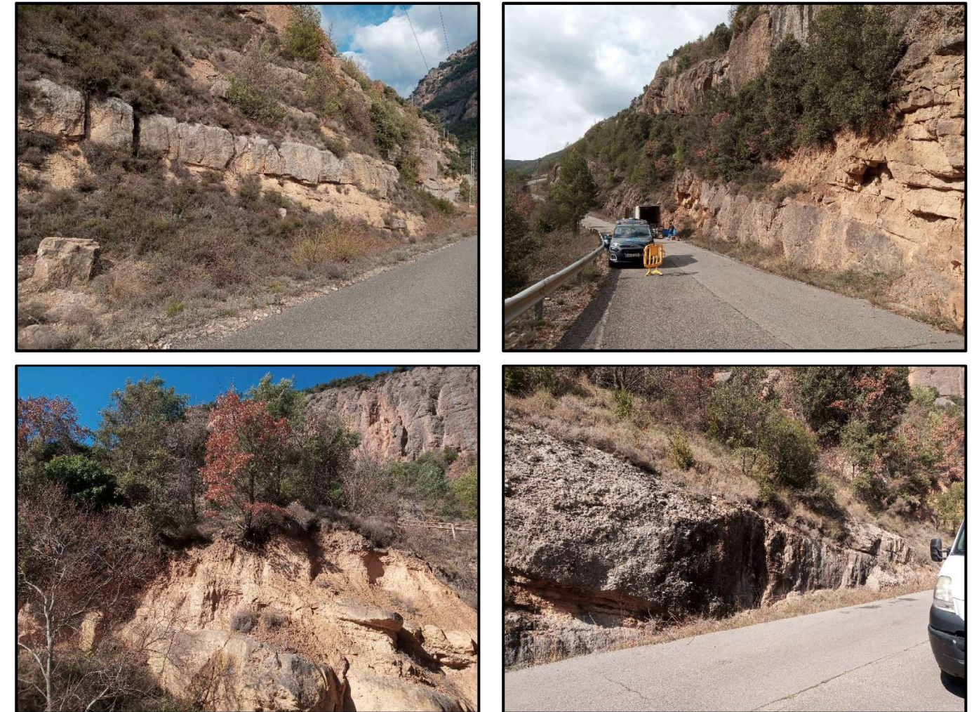
Diferentes afloramientos del sustrato Oligoceno a lo largo del margen occidental del vial de acceso al embalse. Se observa una alternancia de materiales, entre niveles de lutita, arenisca y conglomerado.
