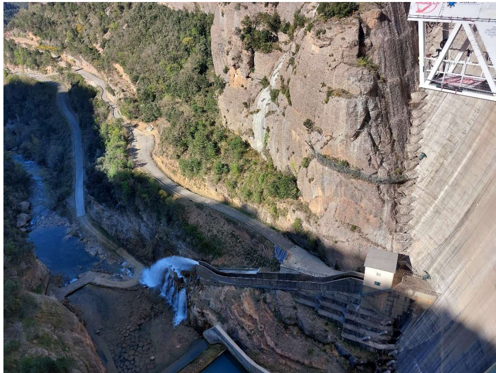
Fotografia 17. Vista del canal de sortida de la línia de cabals de manteniment des de l'estrep esquerre.
