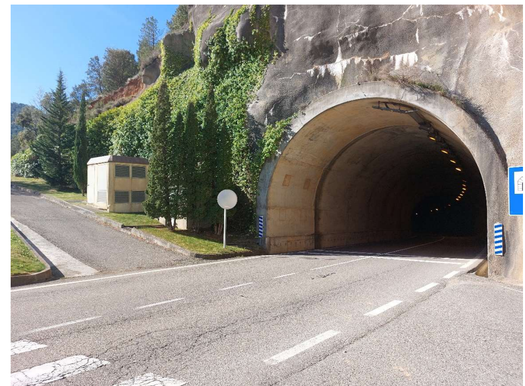
Fotografia 10. Vista de la sortida del túnel a l'estrep dret de la presa.
