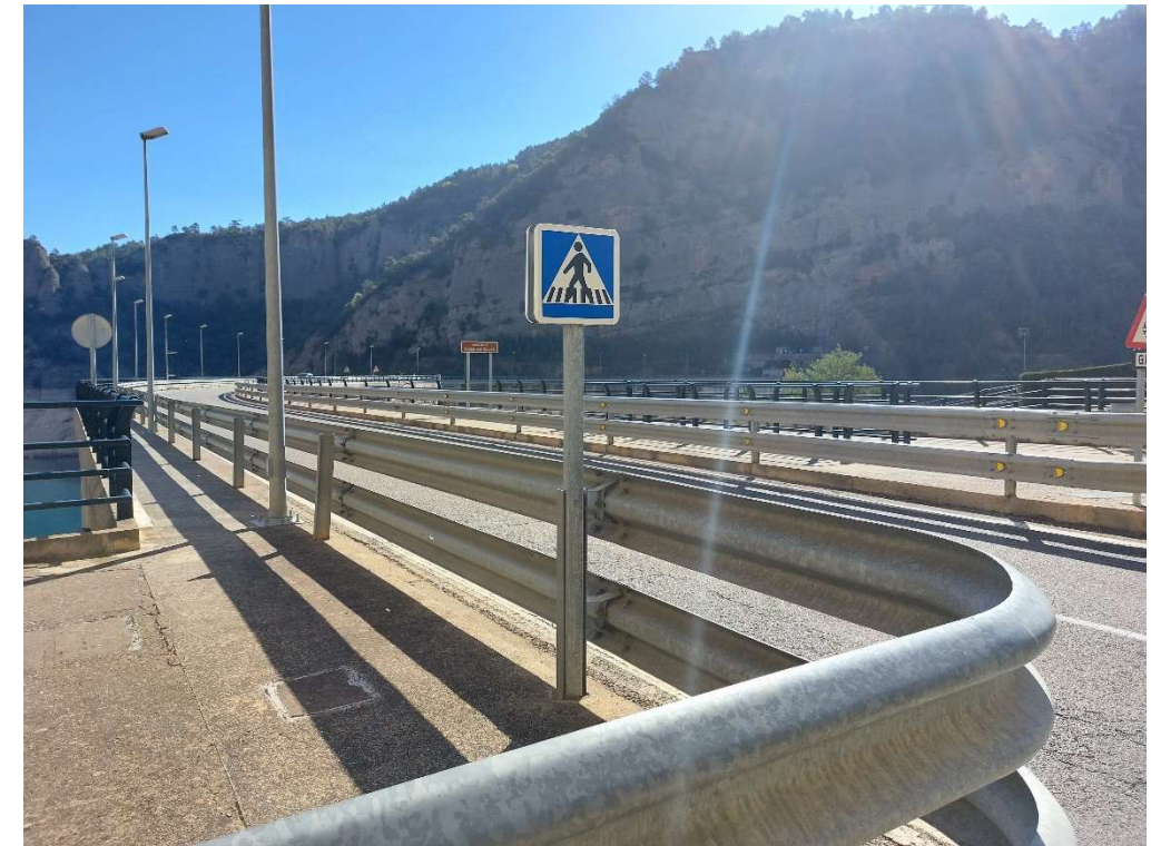
Fotografia 9. Vista de la carretera que creua el coronament de la presa.
