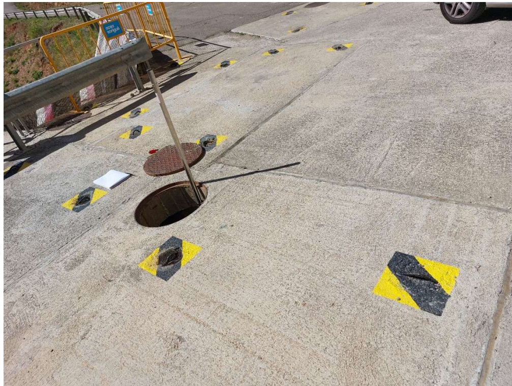
Fotografia 57. Accés i llosa superior de la cambra de vàlvules de la línia de cabals de manteniment.
