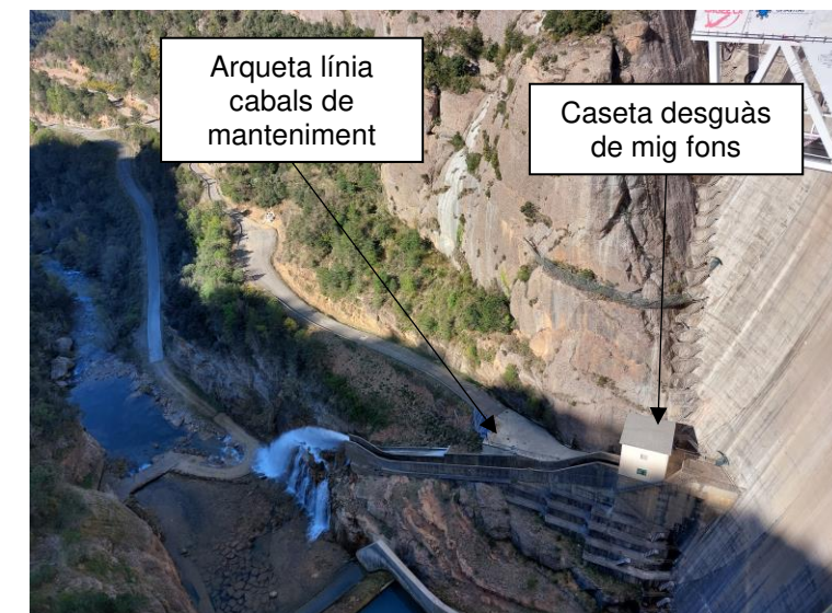
Figura 2. Vista del parament d'aigües avall de la presa amb la caseta del desguàs de mig fons i l'arqueta de vàlvules de la línia de cabals de manteniment
