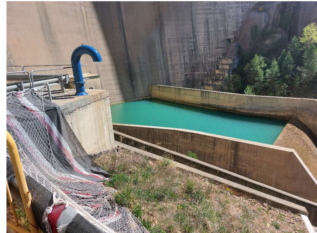
Fotografia 59. Tram soterrat de la conducció de 1,2x1,2 m de sortida de la línia de cabals de manteniment.
