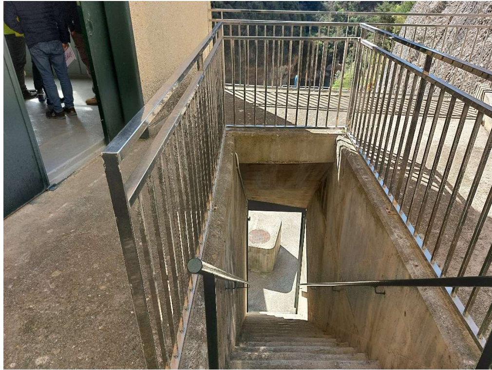
Fotografia 35. Escala d'accés a la cambra de vàlvules del desguàs de mig fons.
