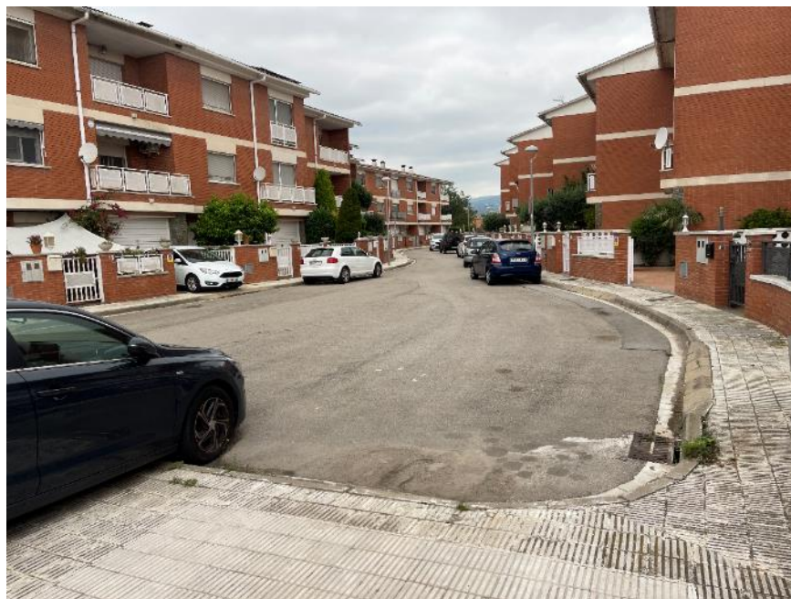
Foto 12 Carrer Gregal Sud
