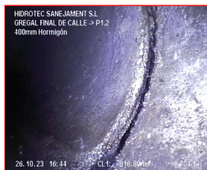
Junta abierta a 16,8 metros
