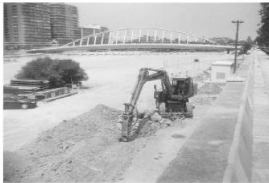
DEMOLICIÓN MECÁNICA A CIELO ABIERTO
