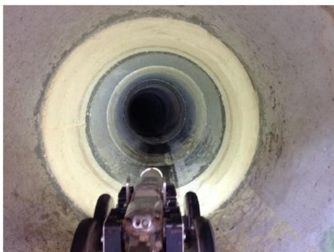
Detall de Part-Linnings col·locat en un col·lector de formigó DN 600
