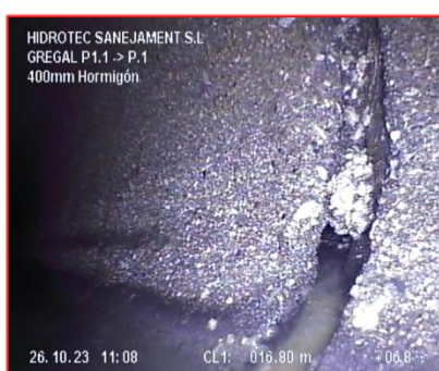
Junta abierta a 16,80 metros
