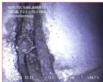
Junta abierta a 7,5 metros
