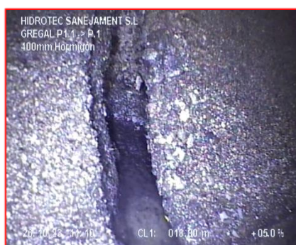
Junta abierta a 18,8 metros
