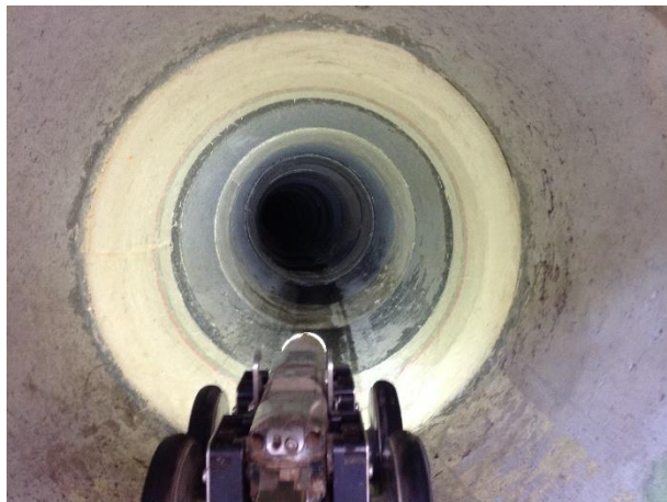
Detalle de Part-Linings colocados en colector de hormigón DN 600.
