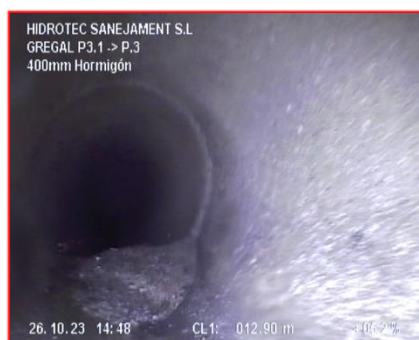
Incrustación a 13 metros
