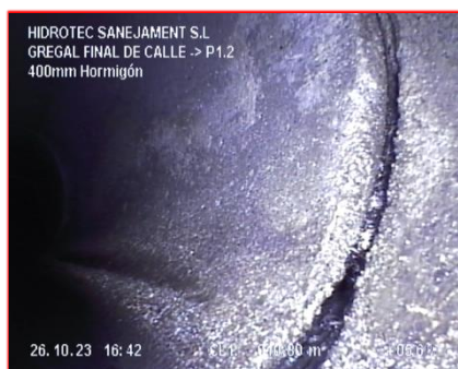
Junta abierta a 10,9 metros
