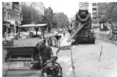
VERTIDO DE HORMIGÓN DE FIRME
