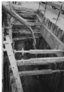
VERTIDO DE HORMIGÓN DE RECUBRIMIENTO
