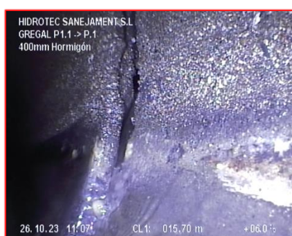
Junta abierta a 15,7 metros
