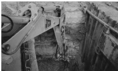
DEMOLICIÓN MECÁNICA EN ZANJA
