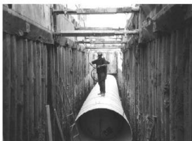
COLOCACIÓN TUBERÍA DE PVC. (RIB-LOC)
