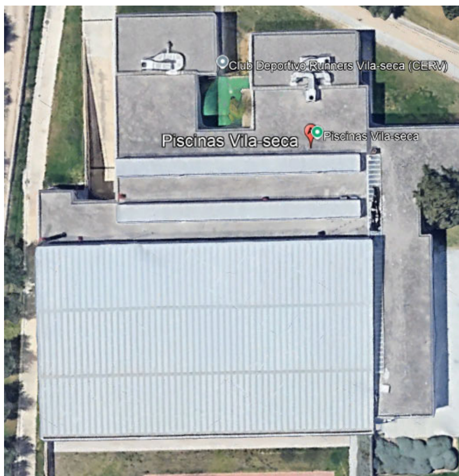
Figura 1 Imatges estructura de coberta (font Google Earth)
