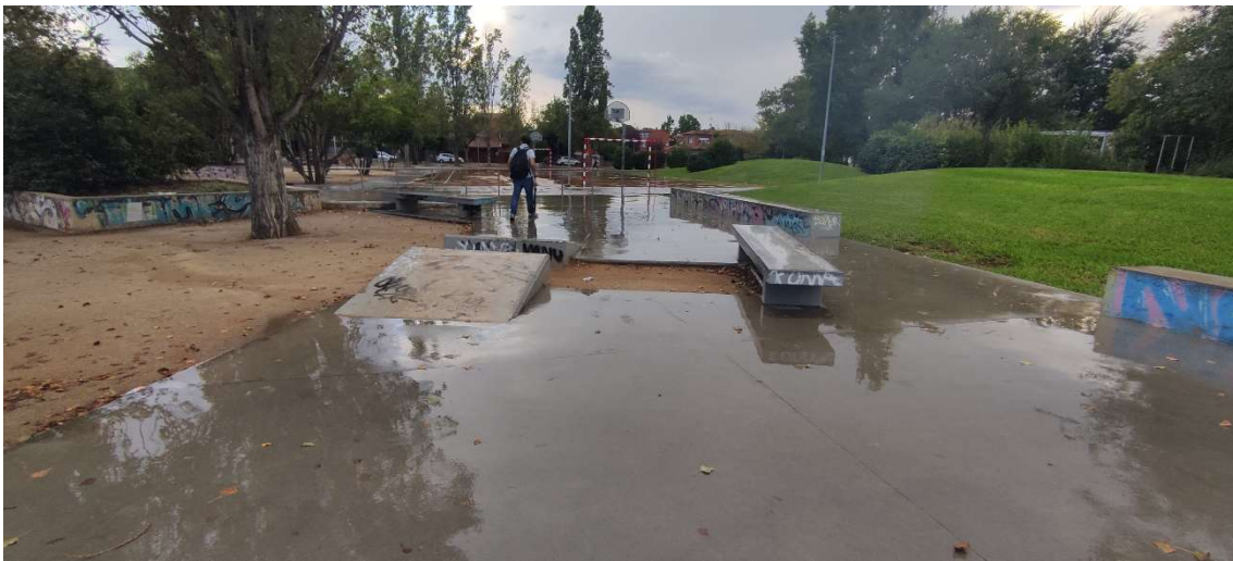
Vista de l'skatepark des de la solera actual. El projecte creix a la banda sud de l'skatepark actual (banda esquerra de la fotografia).
