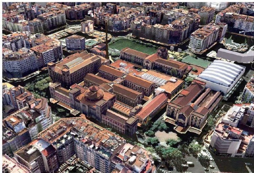
Edifici 12 existent a l'interior del recinte de l'Escola Industrial
