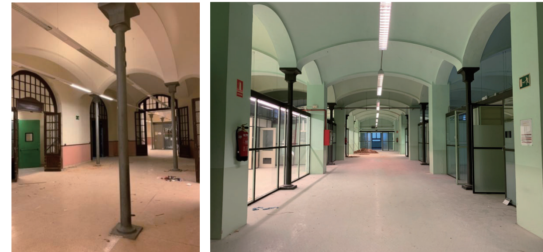
Pilars vistos de ferro colat de la planta Guastavino
