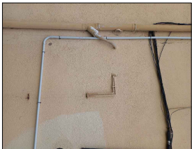
Repassar instalações obsoletas
