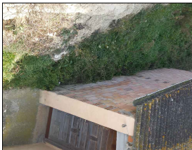
Mitja canya per treure de la paret. Arrebassar i pintar mur |
