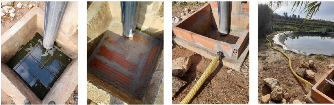
Obstrucció de l'entrada a la llacuna de maduració mitjançant arqueta i canonada flexible provisionals.
