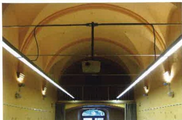
Detall de la volta de canó amb llunetes amb el cor i la porta de sortida al fons
