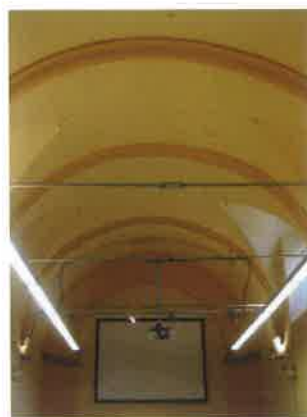
Detall de la volta de canó amb llunetes i amb capçalera de la nau al fons, espai habilitat com a sala polivalent de la Biblioteca Pública
