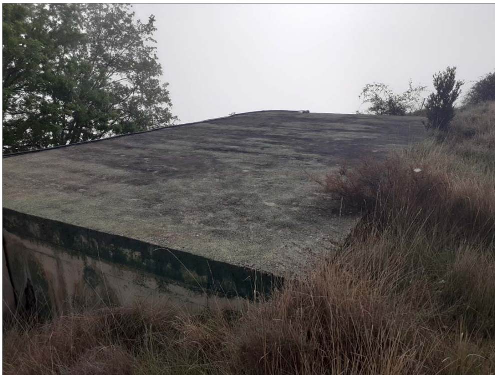
Fotografia 1: Vista exterior del dipòsit d'aigua potable de Fígols.
