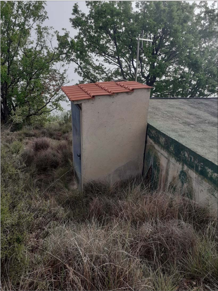
Fotografia 2: Vista exterior de la caseta del dipòsit de Figols.
