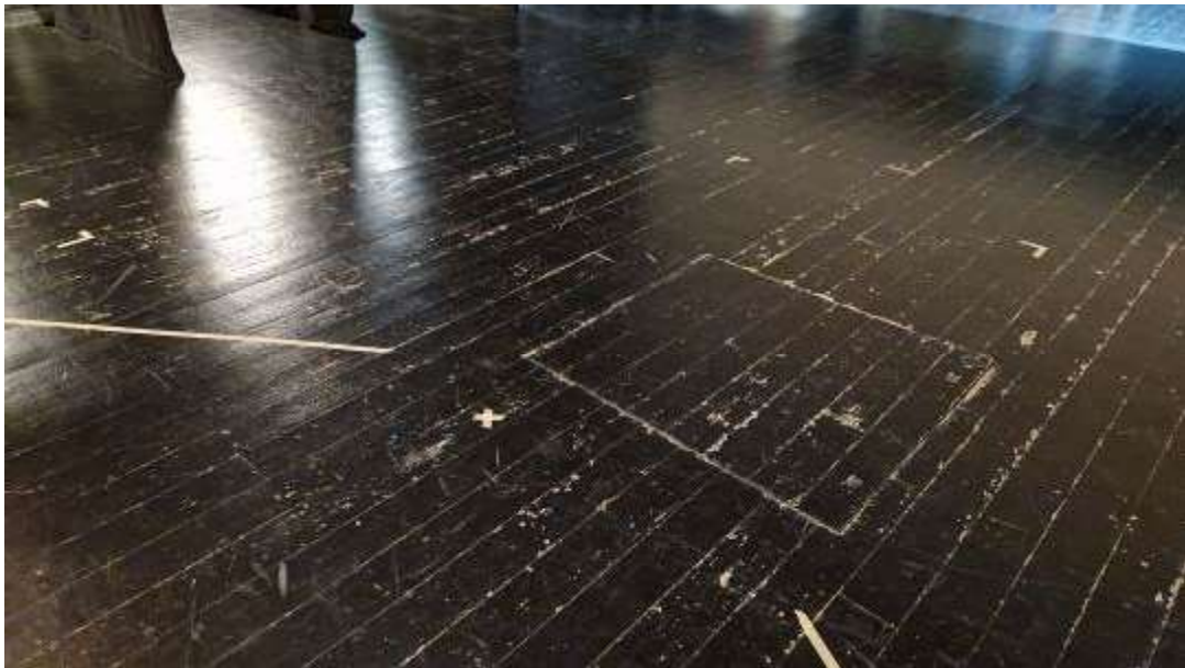
Vista paviment actual escenari
