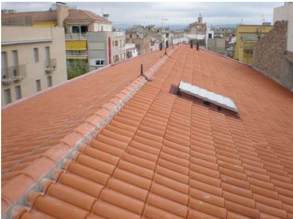
Imatge del exutori situat a la coberta de l'immoble.
