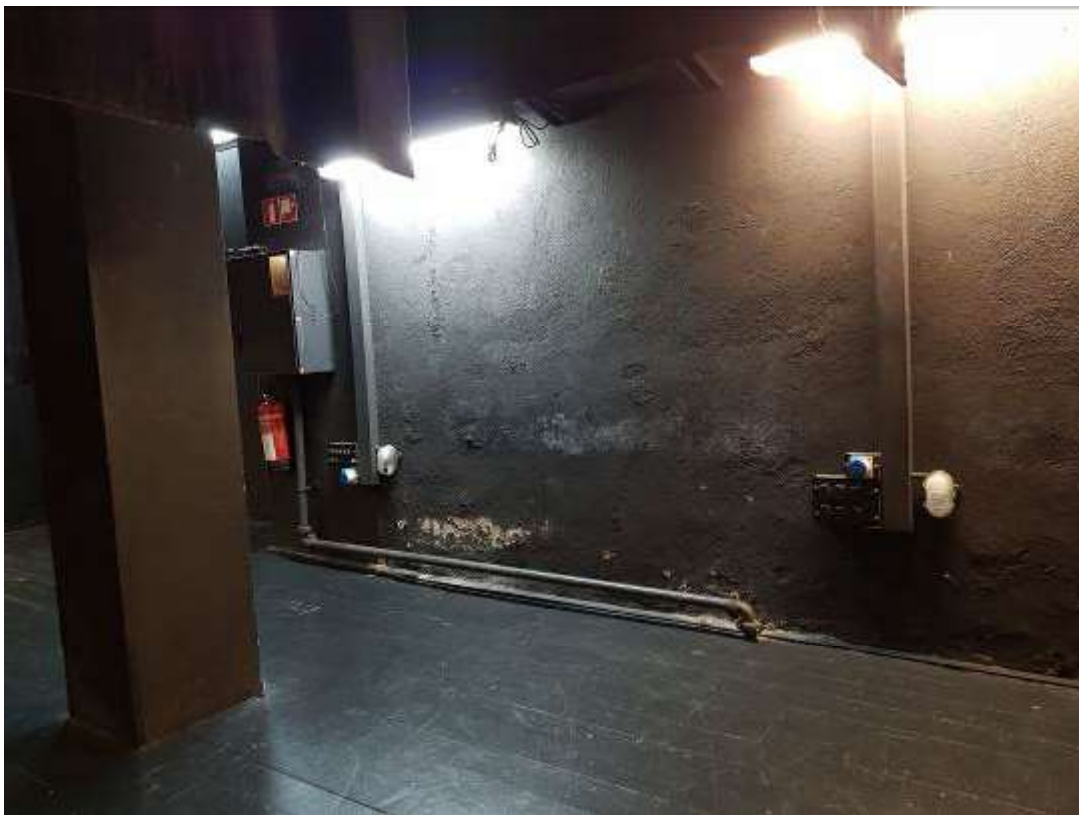
Vista revestiment maltsimesos per humitat capilarirar paret escenari.
