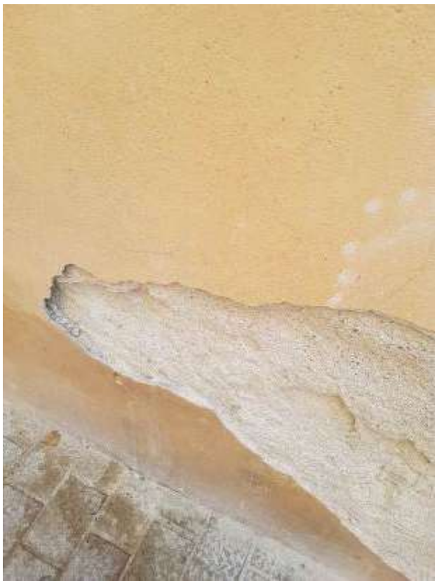
Foto 03. Detalls de pèrdua local de revestiments
