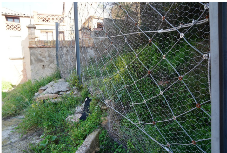
Figura 8. Barrera estàtica existent a l'extrem sud del vessant.
