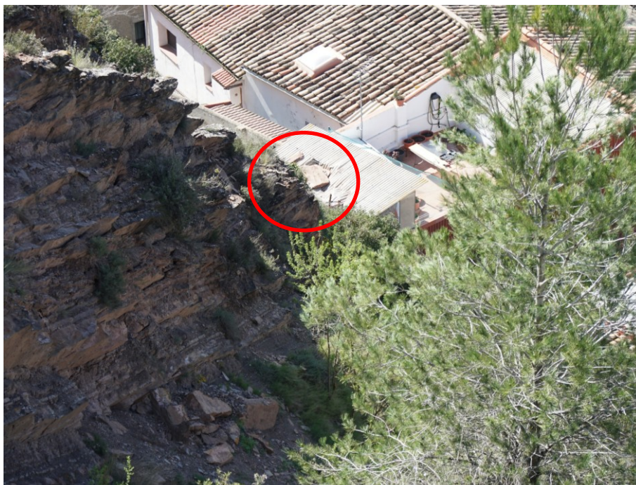
Figura 5. Blocs suspesos en l'estructura del cobert
