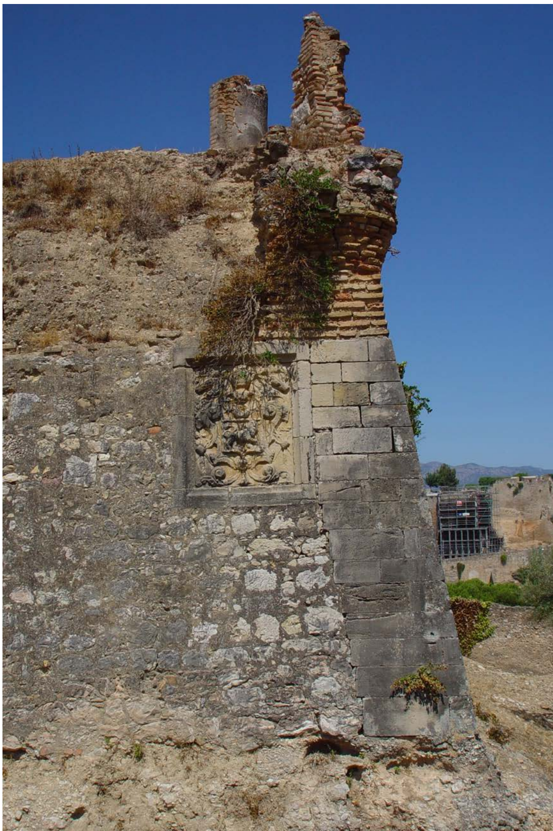
Detall de la cantonada frontal amb escut nobiliari
