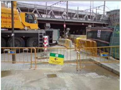
Foto 02: Quan s'ubiqui una grua mòbil o camió grua en exterior d'àmbit d'obra, aquesta zona quedarà delimitada i senyalitzada en tot moment.
