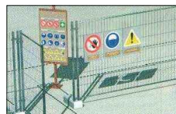
ACCÉS D'OPERARIS A OBRA
