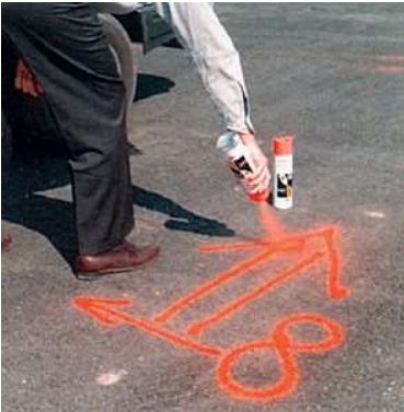
Foto 02: Totes les instal·lacions detectades es deixaran marcades a obra
