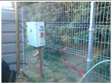
Foto 05: Tindrem cura de les instal·lacions provisionals d'obra.
