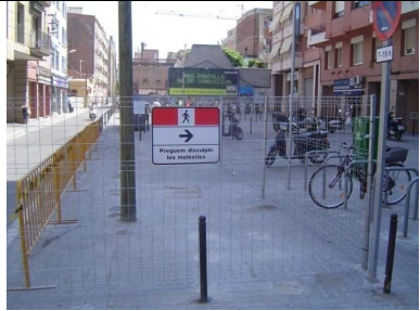
Foto 03: Les zones exteriors d'obra estaran degudament senyalitzades
