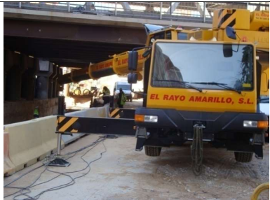
Foto 01: Per grues autopropulsades, abans de la seva utilització es realitzarà una implantació de la grua amb l'obertura de les potes tal i com s'indica al manual d'ús de la grua.
