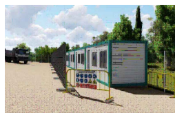
CASETES D'OBRA, DELIMITADES AMB TANCA TIPUS RIVISA AMB BASE DE FORMIGÓ.
