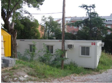
Foto 04: Abans inici obra s'instal·laran les casetes d'obra.
