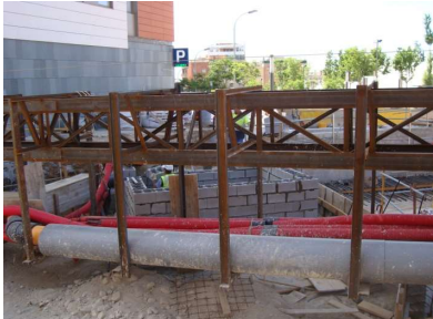
Foto 01: Abans d'iniciar els treballs, els serveis existents es protegiran o desviaran a fi d'evitar possibles riscos.
