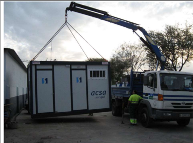
Foto 03: Els materials a carregar – descarregar estaran degudament subjectats amb les eslingues
