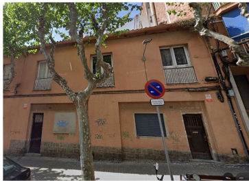
Fotografia 4: Accés secundari pel carrer de la Plaça
