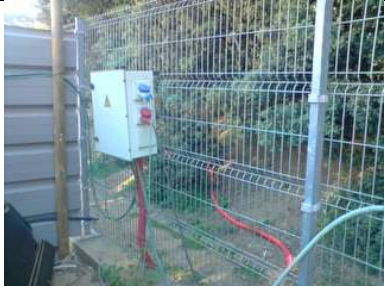
Foto 06: Tindrem cura de les instal·lacions provisionals d'obra.
