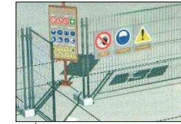
ACCÉS D'OPERARIS A OBRA
