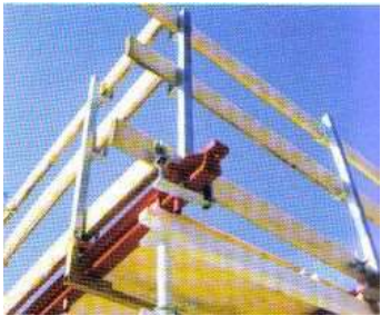
Foto 02: Els puntals a utilitzar estaran en un bon estat ús, en cas contrari no es col·locaran
