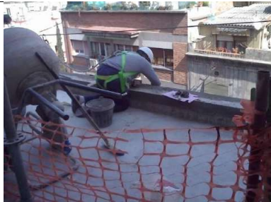
Foto 01: En tot moment els operaris portaran arnès de seguretat i es lligaran a les línies de vida habilitades.
