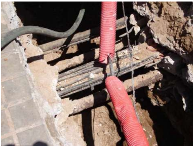
Foto 02: Es realitzaran cales per localitzar els serveis existents a la zona abans d'iniciar els treballs d'excavacions.
