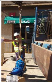
Foto 04: Per descarregar materials a interior de rases, es realitzarà amb camió grua o grua mòbil.
