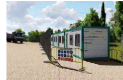
CASETES D'OBRA, DELIMITADES AMB TANCA TIPUS RIVISA AMB BASE DE FORMIGÓ.
