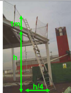
Foto 02: Les escales de mà estaran degudament col·locades i ancorades a la seva part superior
