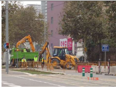
Foto 01: Abans d'iniciar treballs, es realitzarà tancament de tot el perímetre d'actuació.
