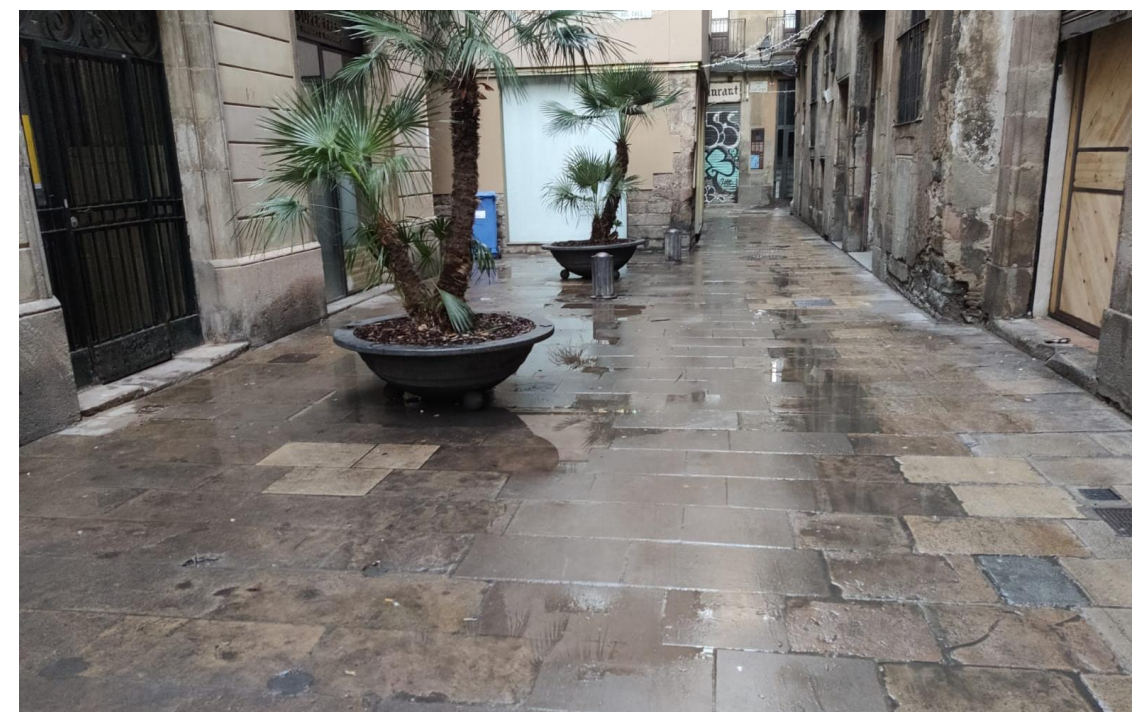
Figura 5. Reparació de paviment en franja central, amb cotes més elevades que el paviment al voltant.
