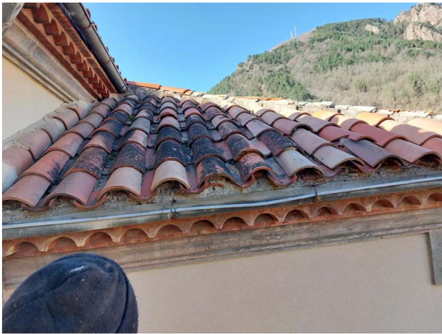
Substitució coberta escola municipal
