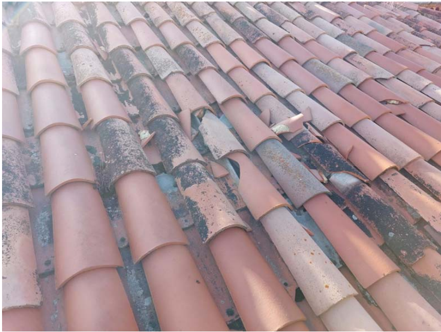
Substitució coberta escola municipal
