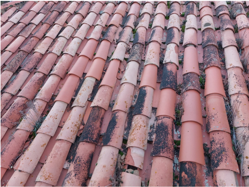
Substitució coberta escola municipal
