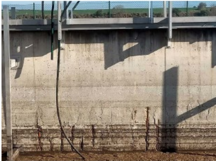
Parets dels reactors
