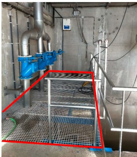
Estructura plataforma pou entrada a substituir
