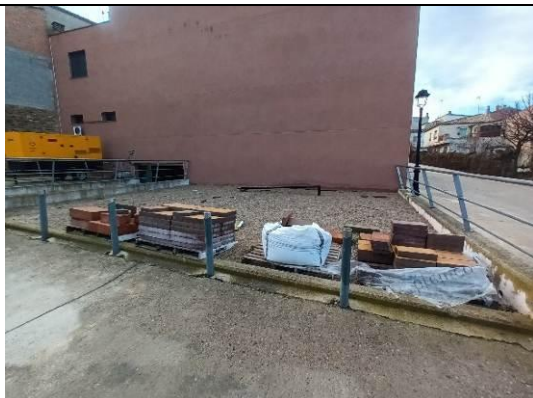
Il·lustració 13 Ubicació Centre de Transformació
