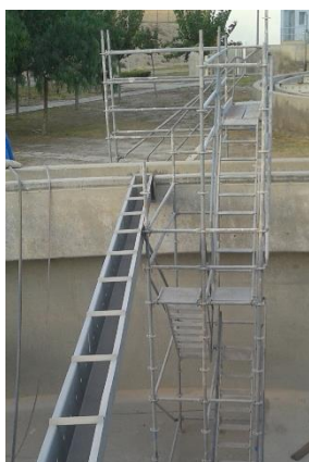
Elementos de una escalera-torre de acceso
