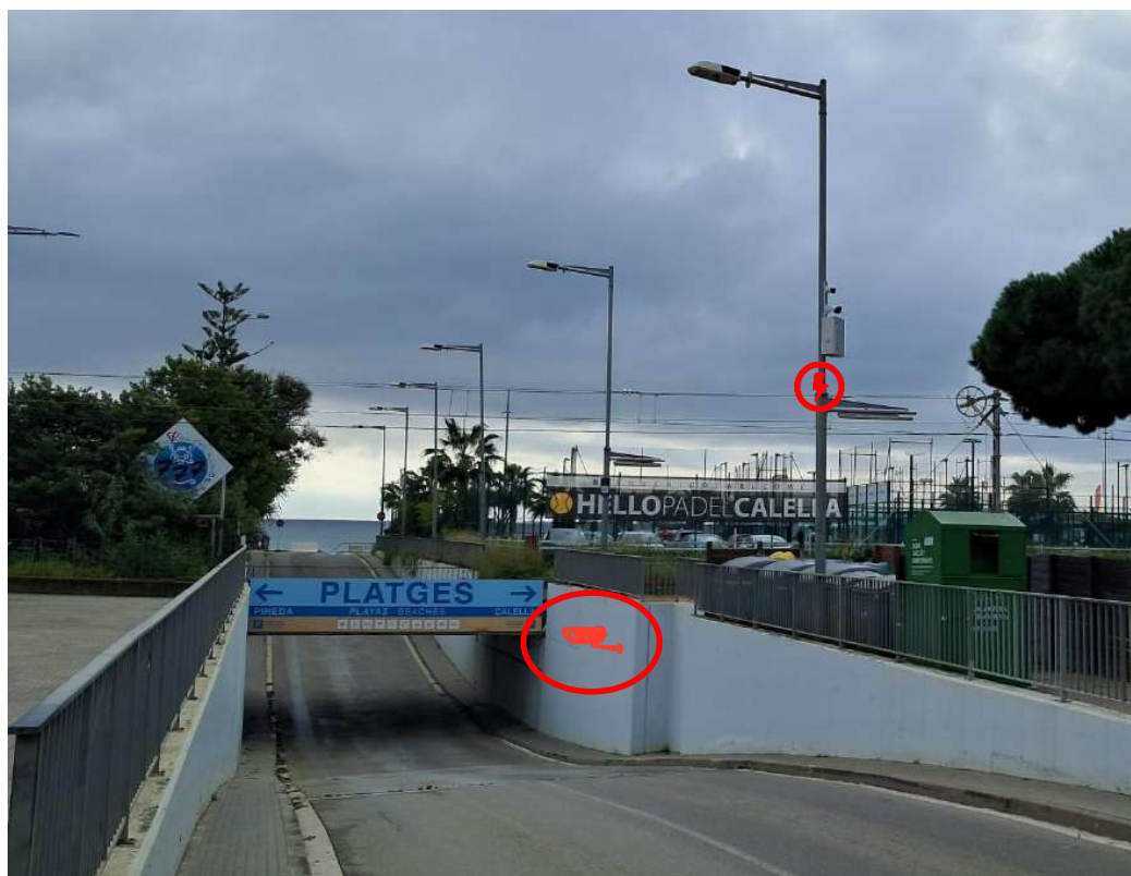
Il·lustració 4 Ubicació Punt CT25 – Càmera circulació vianants
