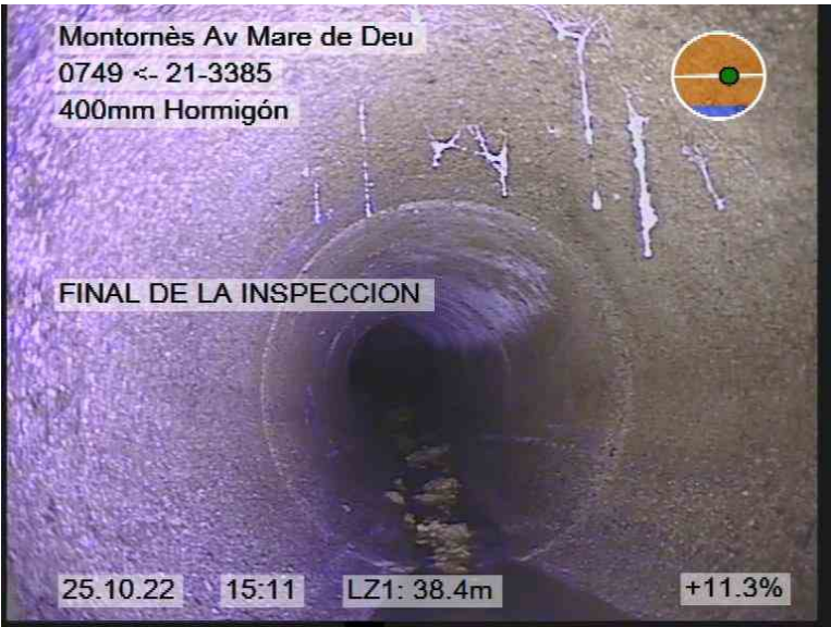
40.jpg, 00:10:44, 38.40m FINAL DE LA INSPECCION
