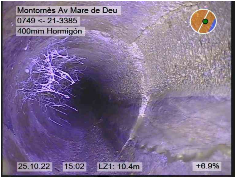
35.jpg, 00:02:27, 10.40m ROTURA PUNTUAL desde 12 Reloj a 9 Reloj
