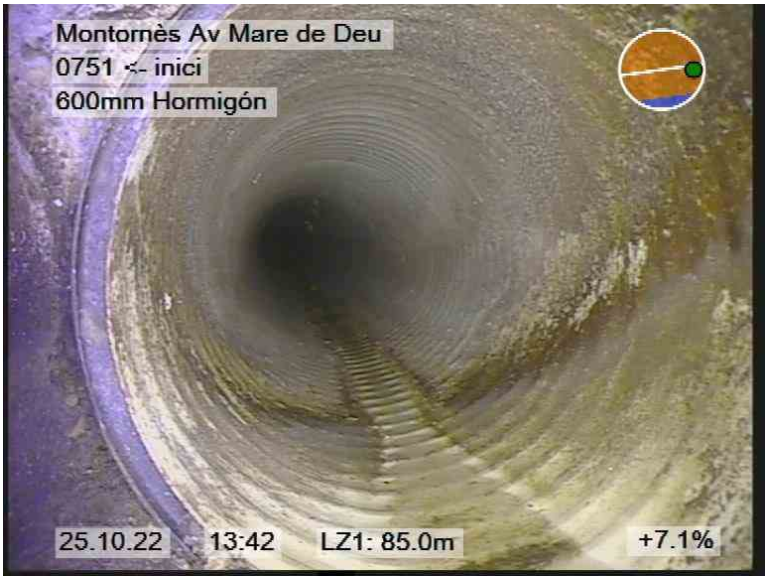
11.jpg, 00:07:22, 85.00m POZO INTERMEDIO CON 2 ACOMETIDAS
