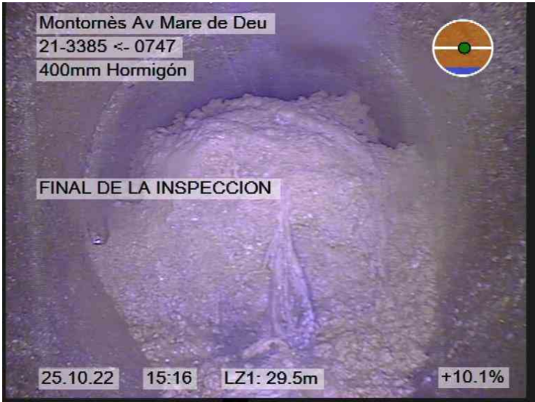
44.jpg, 00:03:30, 29.50m FINAL DE LA INSPECCION
