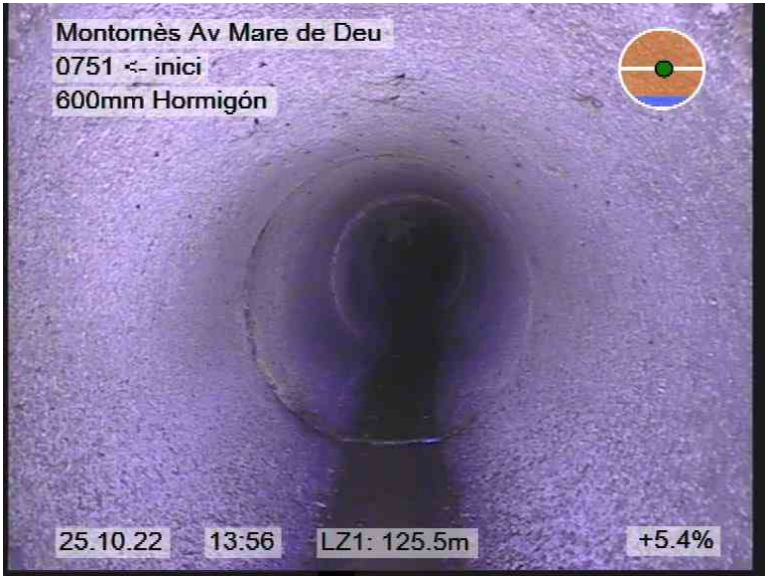
20.jpg, 00:13:12, 125.50m INTERRUPCION POR CAMBIO DE DIAMETRO
