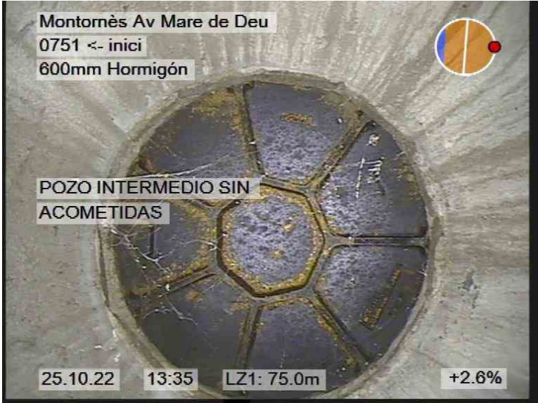
7.jpg, 00:05:38, 75.00m POZO INTERMEDIO SIN ACOMETIDAS
