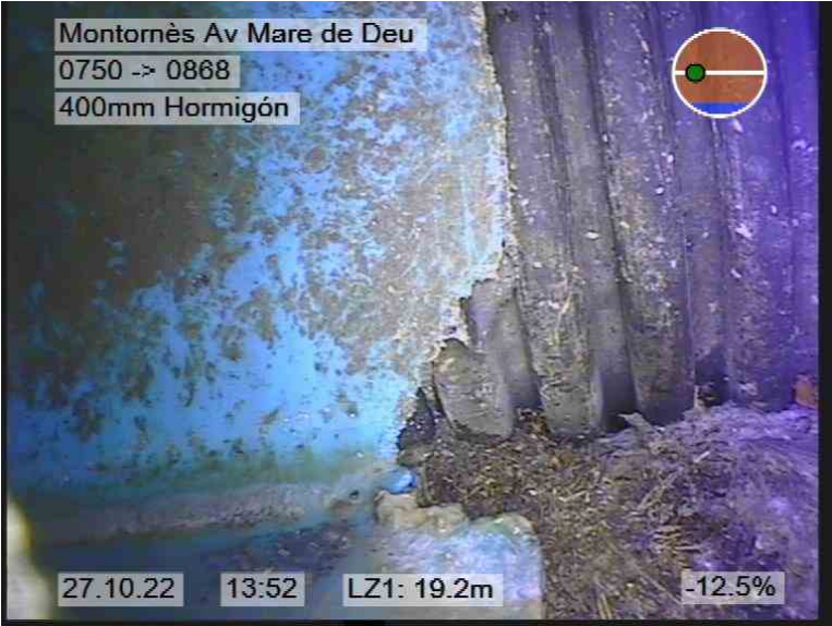
56.jpg, 00:02:02, 19.30m POZO FINAL CON 2 ACOMETIDAS
