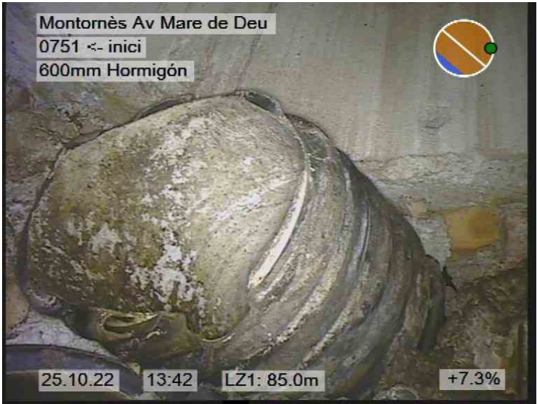
12.jpg, 00:07:22, 85.00m POZO INTERMEDIO CON 2 ACOMETIDAS
