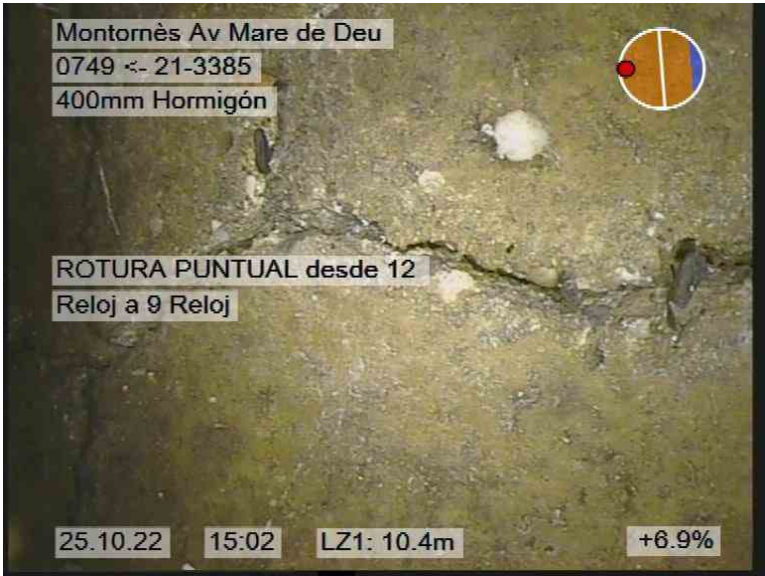
34.jpg, 00:02:27, 10.40m ROTURA PUNTUAL desde 12 Reloj a 9 Reloj
