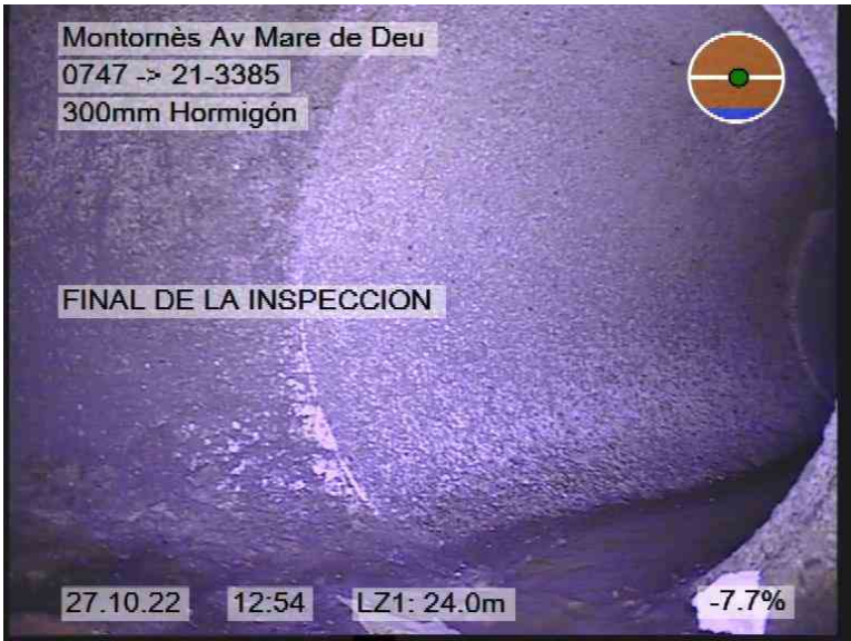
48.jpg, 00:03:01, 24.00m FINAL DE LA INSPECCION
