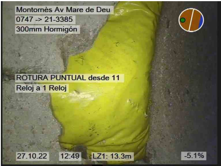
47.jpg, 00:01:02, 13.30m ROTURA PUNTUAL desde 11 Reloj a 1 Reloj
