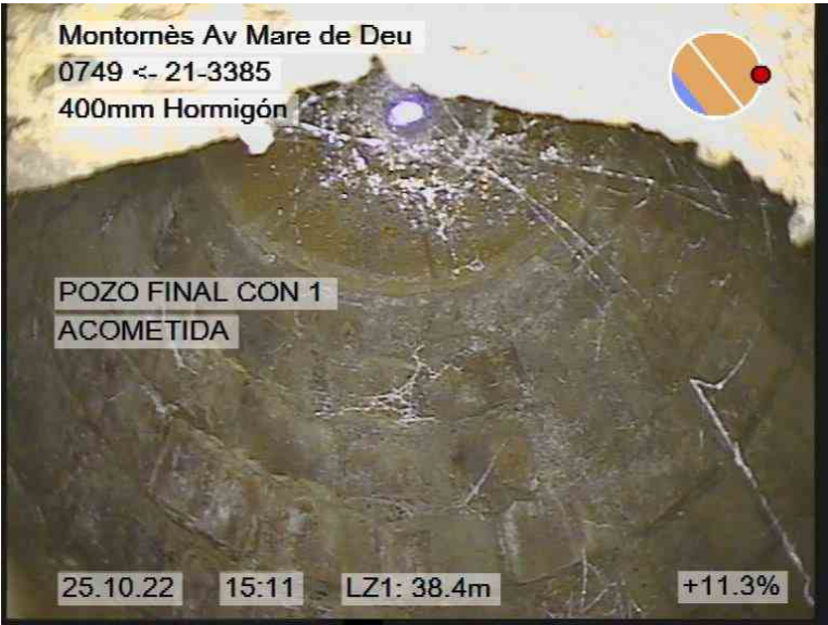
39.jpg, 00:10:24, 38.40m POZO FINAL CON 1 ACOMETIDA
