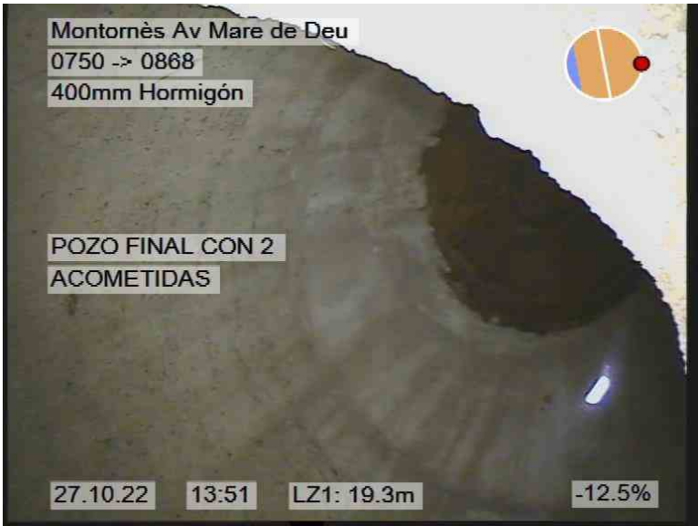
55.jpg, 00:02:02, 19.30m POZO FINAL CON 2 ACOMETIDAS
