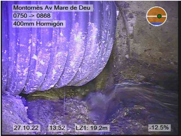
58.jpg, 00:02:36, 19.35m FINAL DE LA INSPECCION
