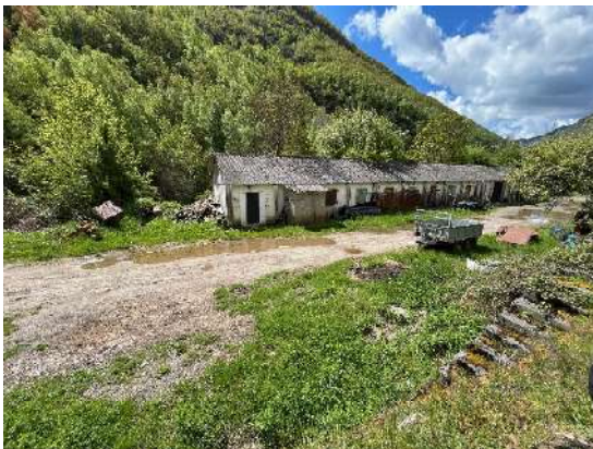
Imatge 03. Estat actual de la zona on s'emplaçarà el pump track, accessos i àmbit.
