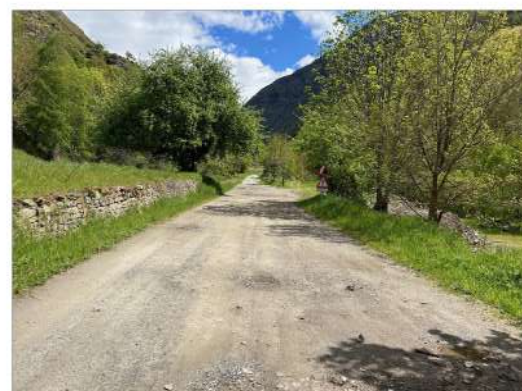
Imatge 06. Estat actual Tram de vial d'accés sense pavimentar
