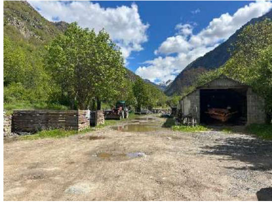
Imatge 02. Estat actual de l'accés a l'actual magatzem municipal.
