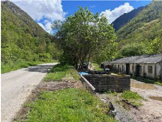
Imatge 01. Estat actual de l'emplaçament de l'aparcament de vehicles, marge dret entre el camí el mur de pedra existent.
