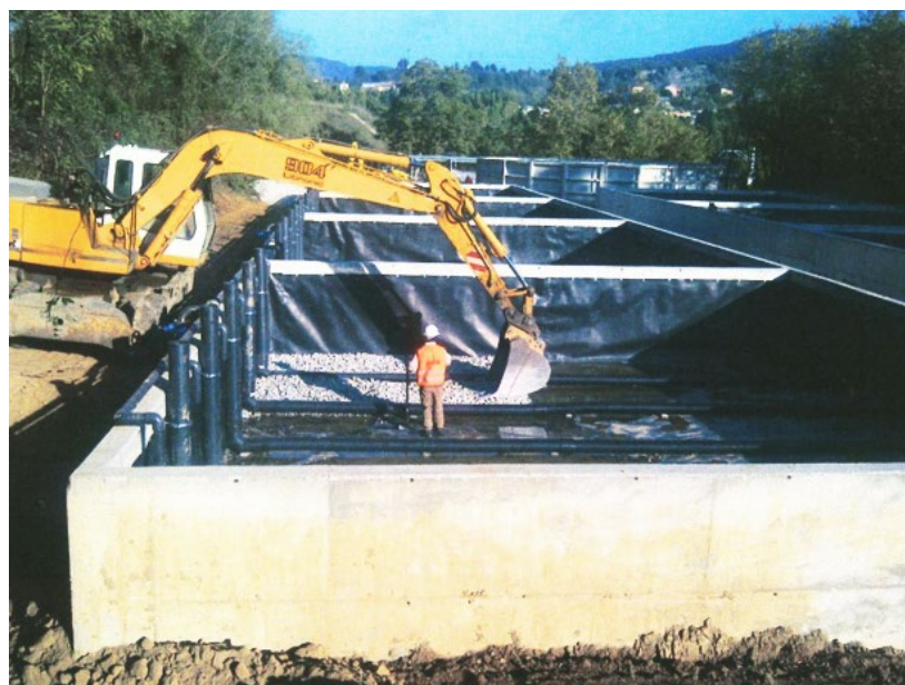
Figura 6. Capa de pedres i graves per sobre els tubs de drenatge que també s'haurà de retirar.
