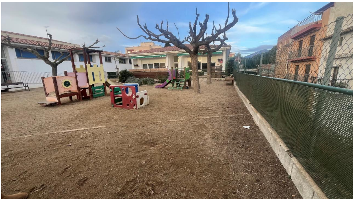
Zona superior del patí de l'escola per localització de serveis, impermeabilització, etc...
