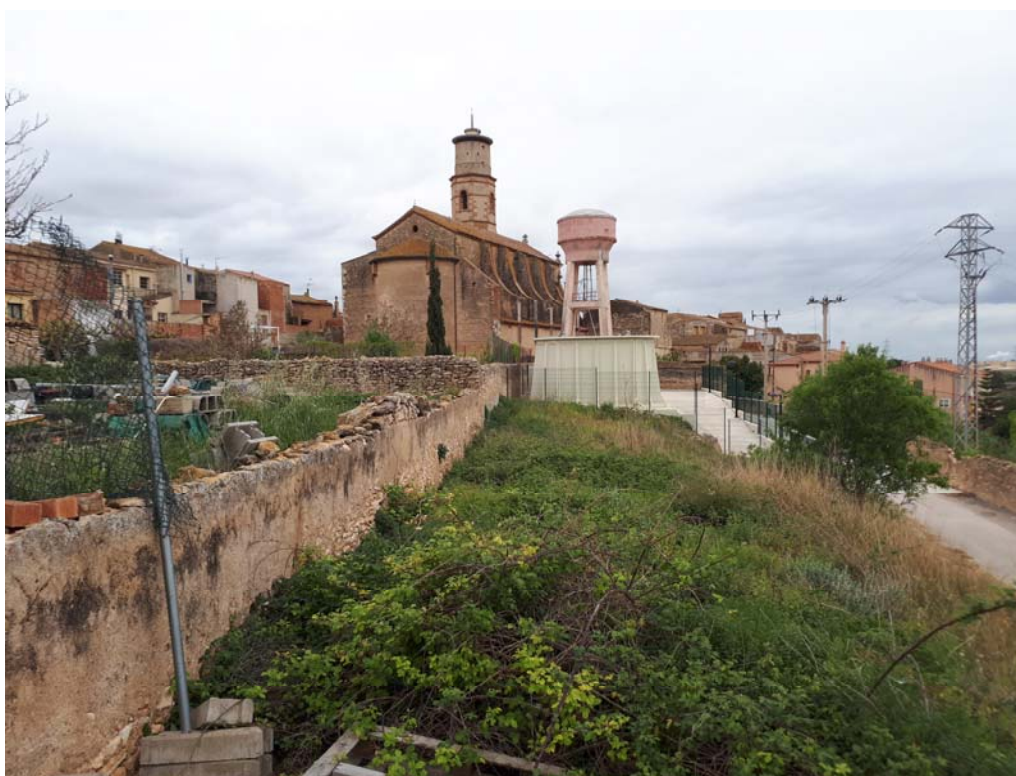
2 Dipòsit de capçalera i distribució d'Alió, prop del centre del nucli urbà
