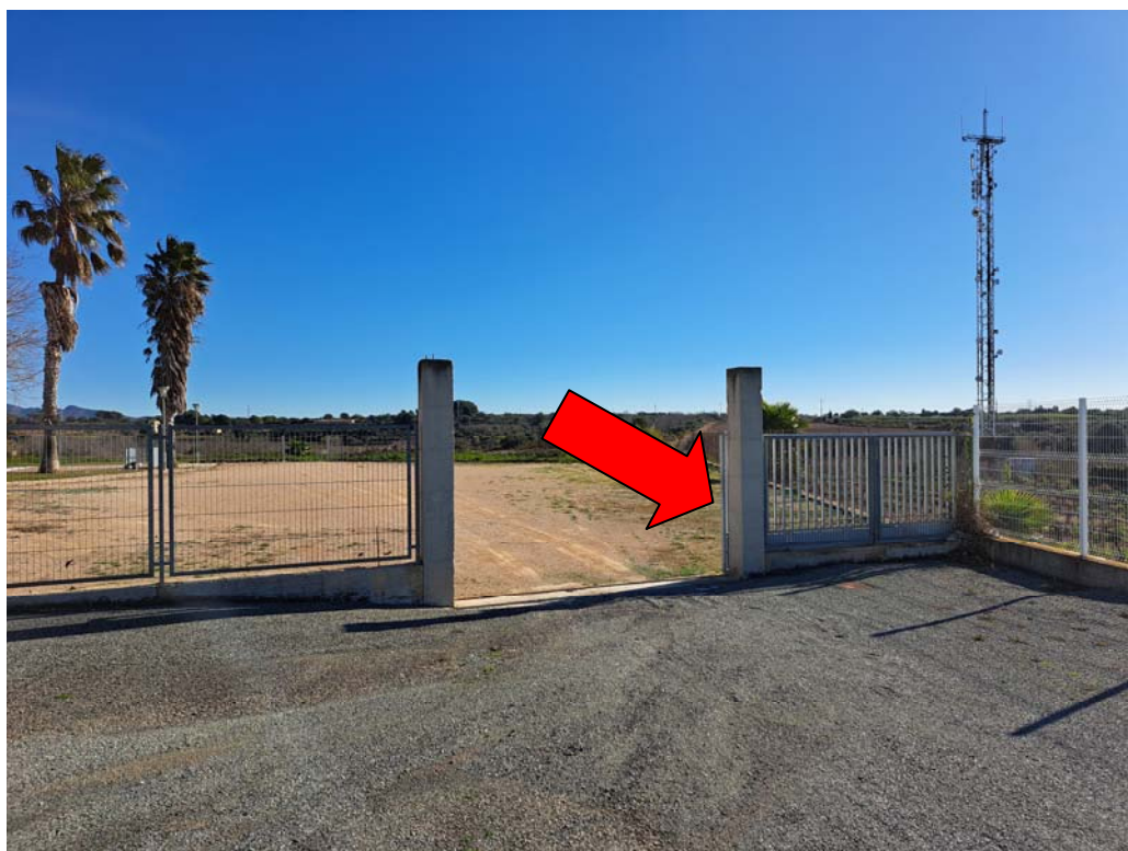
4 Interior del recinte de les piscines, zona on es preveu la perforació del pou 2
