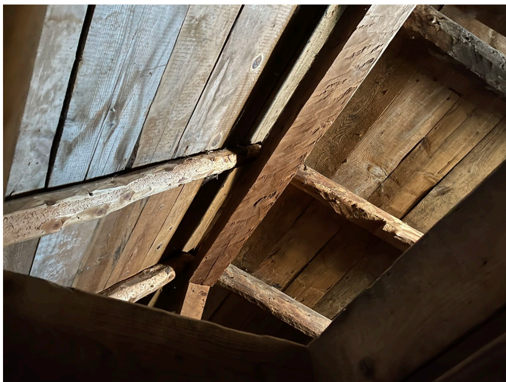
Estructura coberta de bigues de fusta.
