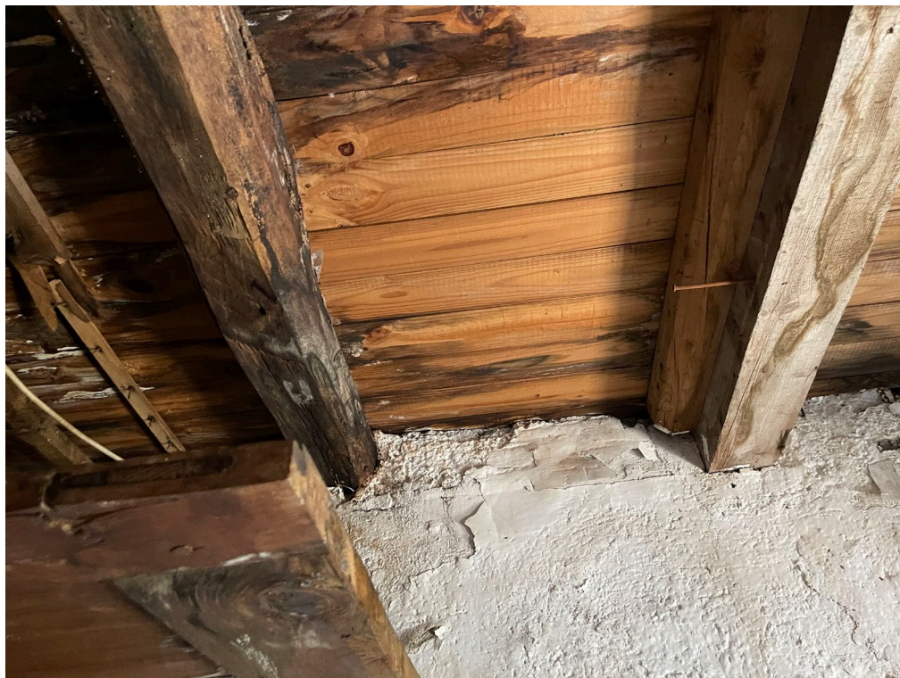
Estructura forjats de fusta.
