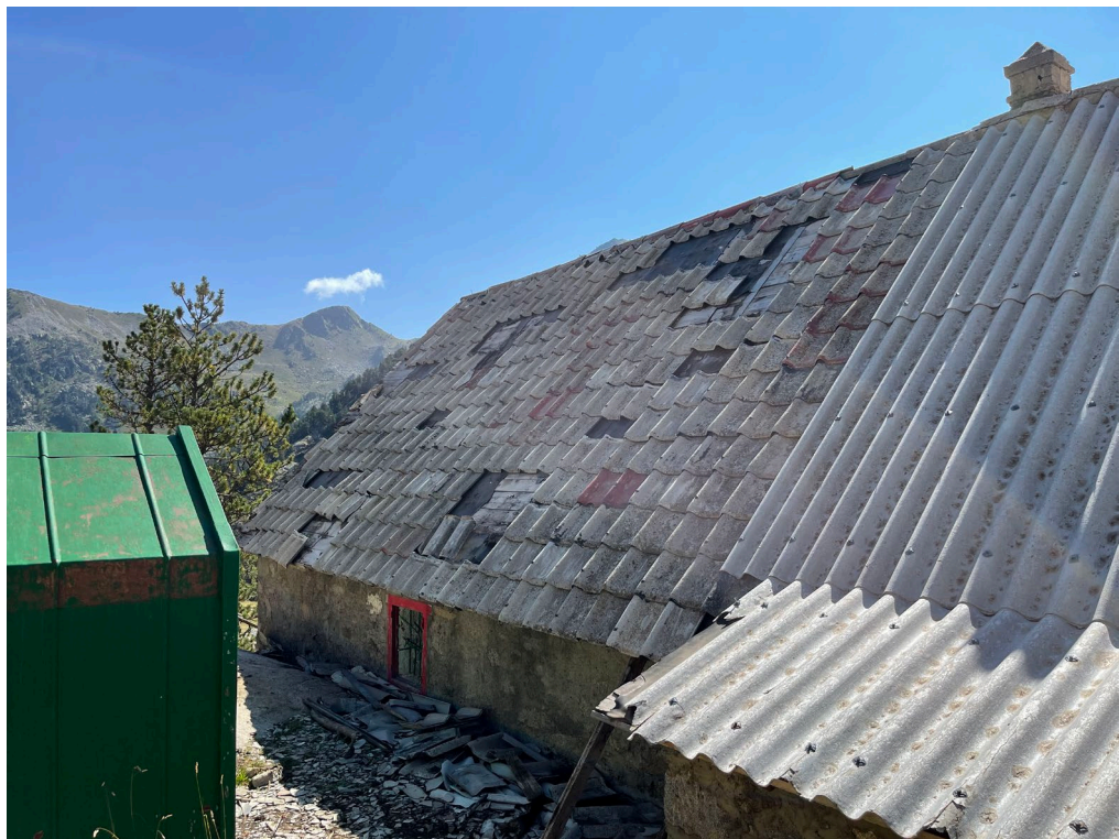
Coberta vessant nord-oest, amb plaques i teules de fibrociment.
