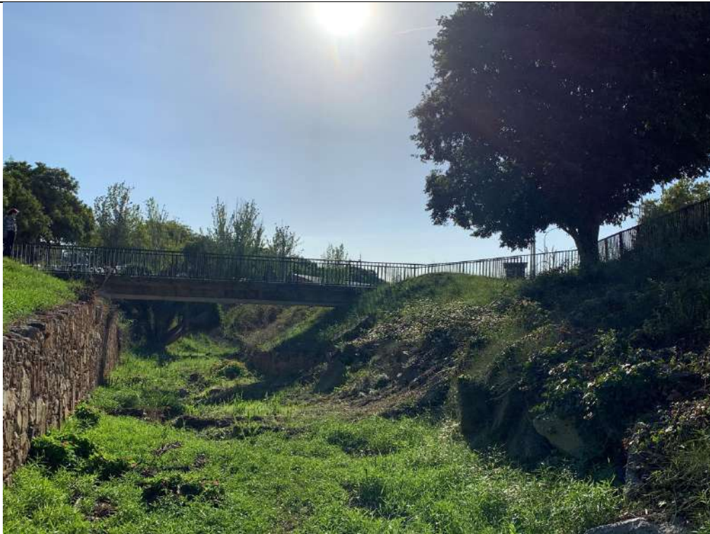
5. Llera zona passera Avinguda de Carlemany
