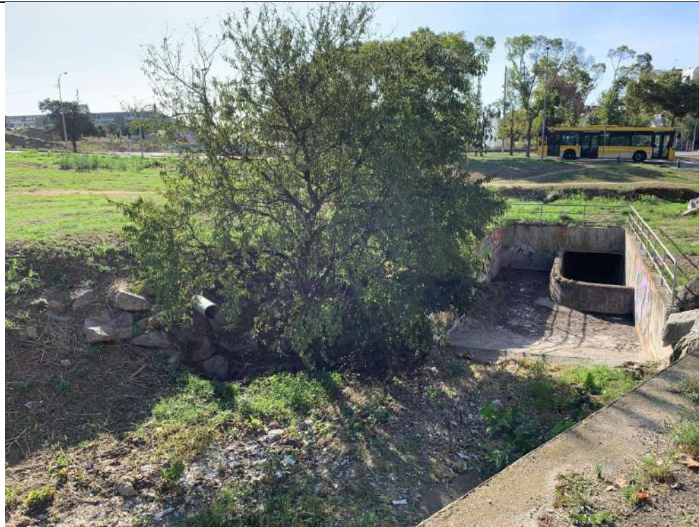
17. Obra d'accés endegament torrent de Canyadó
