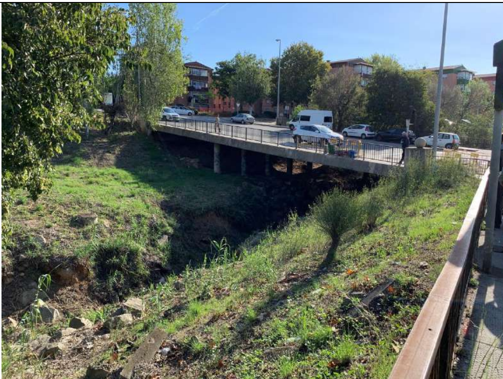
14. Vista pont Bac de Roda, aigües amunt, costat carrer de Juan de Austria
