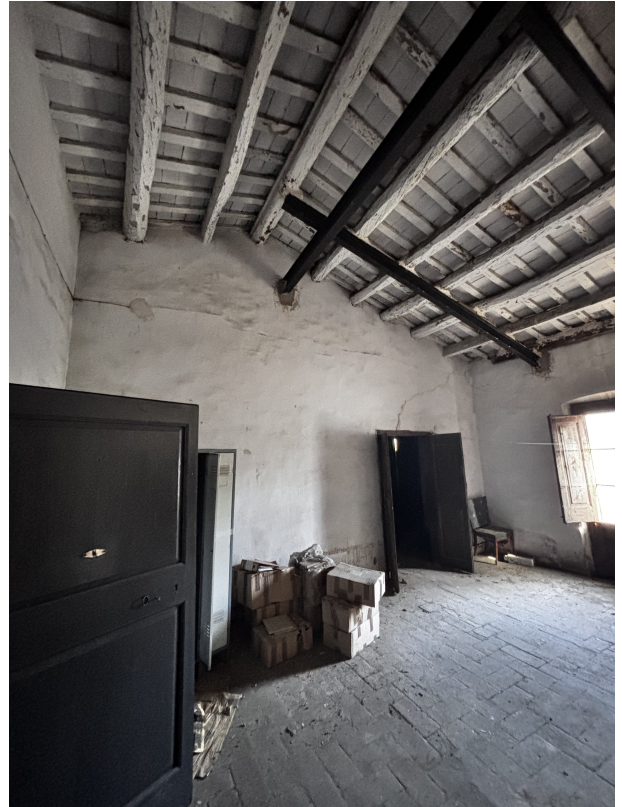
Fotografia golfes sala d'accés.
