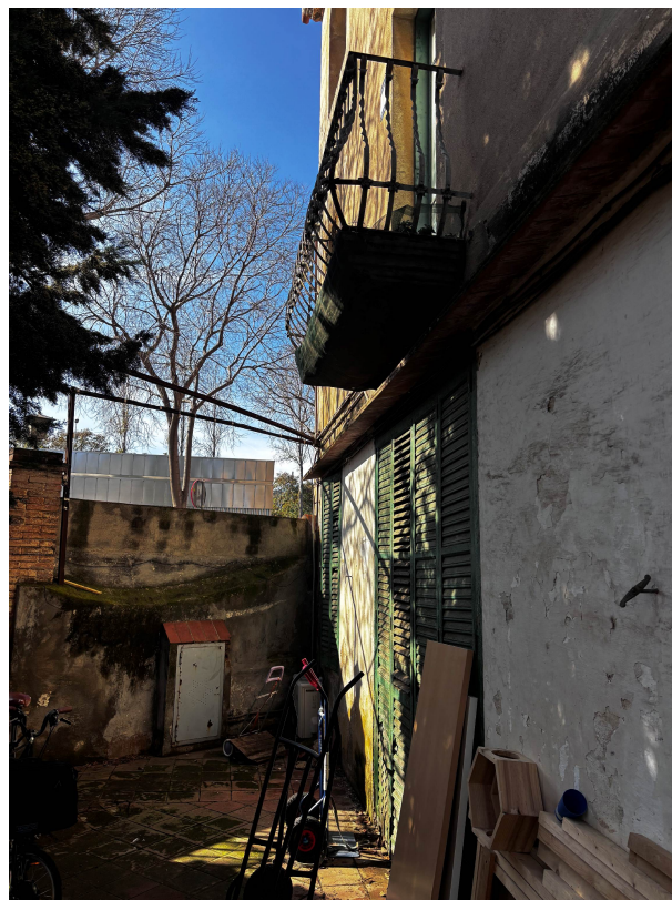
Façana de Can Crehuet i tanca exterior.
